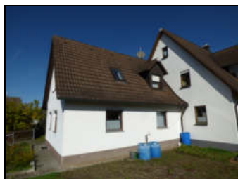
Ansicht „Altbau“ von Südosten (Baujahr ca. 1937, Gartenseite)
