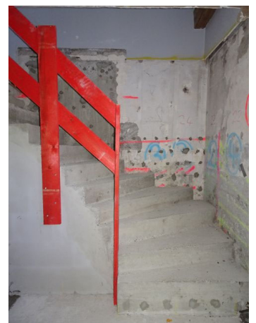
Vorraum mit Treppe
