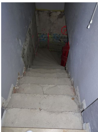
Treppe ins UG
