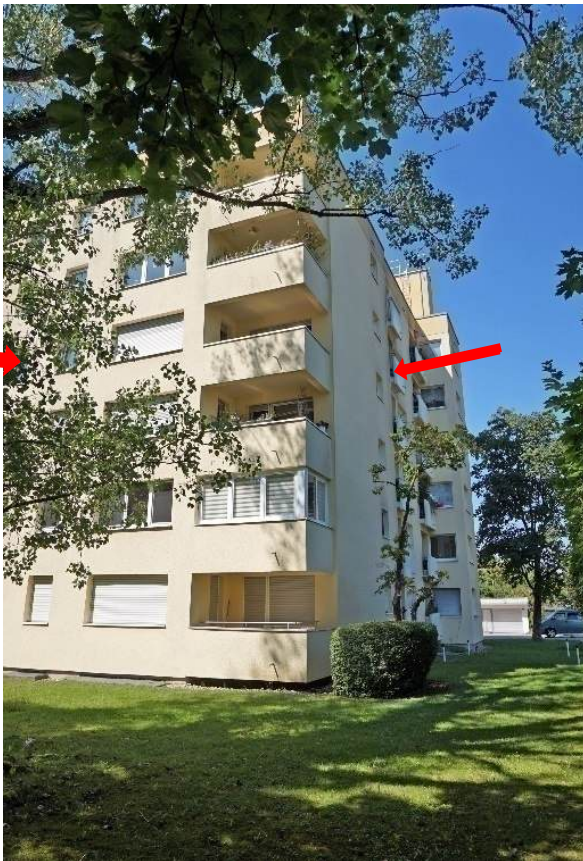
Blick von Südosten auf die 3-Zimmer-Eckwohnung Nr. 127 mit Loggia im 3. OG (mit Pfeilen markiert)
