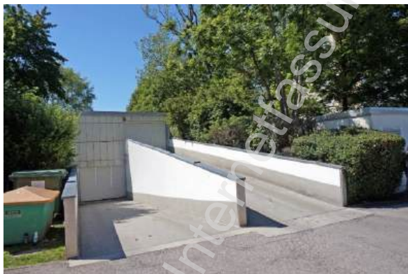
Blick vom Zufahrtsweg auf der Ostseite auf die Einfahrtsrampen des Garagengebäude H
