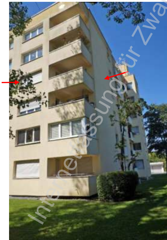
Blick von Südosten auf die 3-Zimmer-Eckwohnung Nr. 127 mit Loggia im 3. OG (mit Pfeilen markiert)
