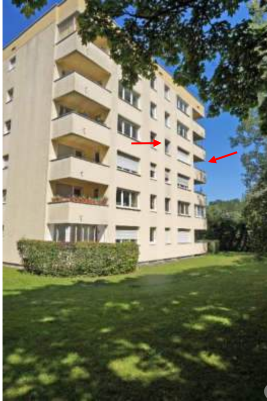
Blick von Südwesten auf die Südseite des Hauses J-H-Str. 4 (Haus A), im 3. OG Eckwohnung Nr. 127 mit Loggia (mit Pfeilen markiert)
