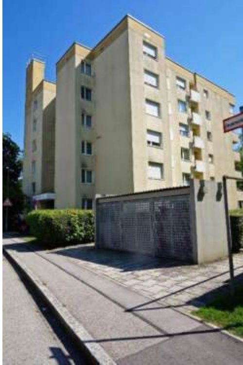
Blick von der Julius-Haerlin-Str. auf die Nord- u. Westseite Haus Nr. 4 (Haus A)
