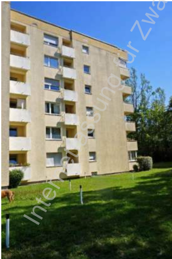
Blick auf die Westfassade des Hauses J-H-Str. 4 (Haus A)
