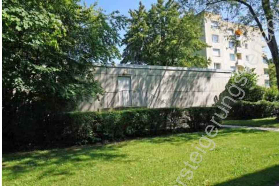
Blick von Südwesten vom Weg auf der Südseite auf die rückwärtige bzw. Südfassade des Garagengebäudes H mit Außentreppe
