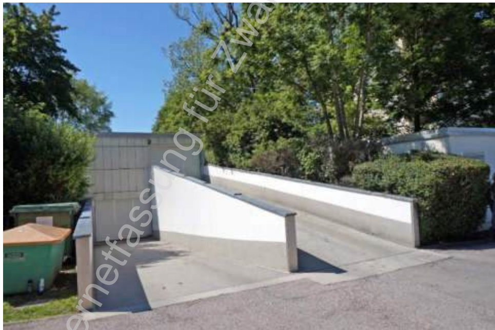
Blick vom Zufahrtsweg auf der Ostseite auf die Einfahrtsrampen des Garagengeb. H
