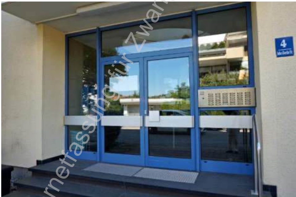
Hauseingang Wohnhaus Julius-Haerlin-Straße 4 (Haus A)
