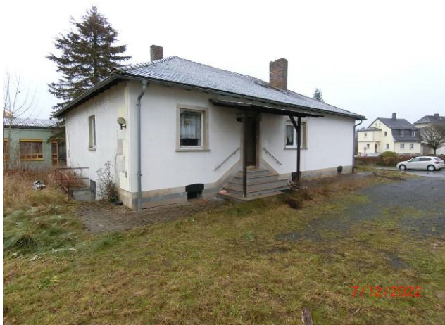
Blick von Nordwesten auf das Bewertungsgrundstück Flst. 102/5 Wohnhaus (Abrissgebäude)
