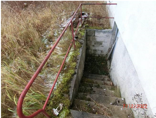
Kelleraußentreppe des Wohnhauses
