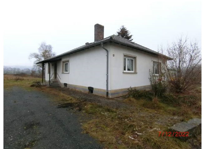
Blick von Südwesten auf das Bewertungsgrundstück Flst. 102/5 Wohnhaus (Abrissgebäude)
