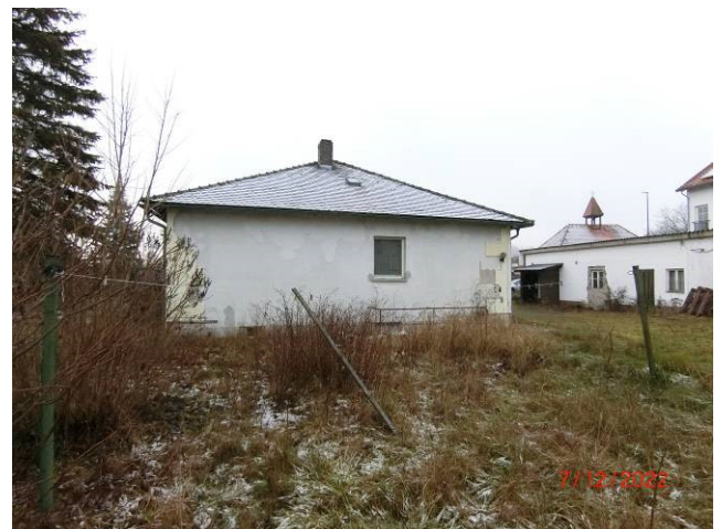
Blick von Norden auf das Bewertungsgrundstück Flst. 102/5 Wohnhaus (Abrissgebäude)
