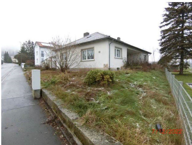
Blick von Südosten auf das Bewertungsgrundstück Flst. 102/5 Wohnhaus (Abrissgebäude)
