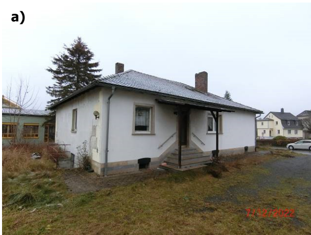
a) Gemarkung Pressig, Flst. 102/5 Angerstraße 12 | 96332 Pressig
