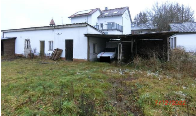
Blick von Nordosten auf das Bewertungsgrundstück Flst. 102/5 Nebengebäude (Abrissgebäude)
