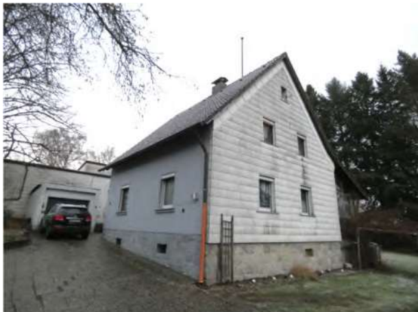
Wohnhaus Ansicht von Westen
