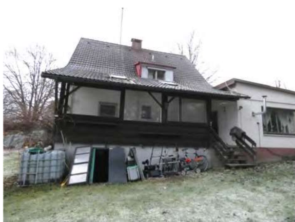
Wohnhaus Ansicht Rückseite
