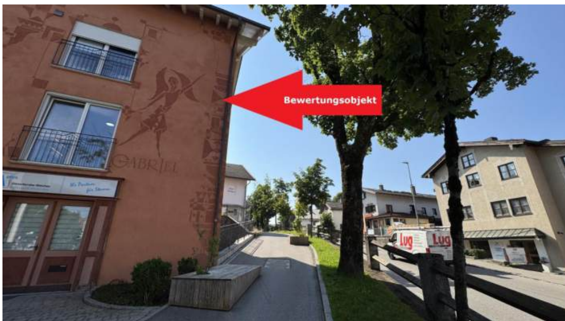
02 Straße Richtung Südost mit Markierung des Bewertungsobjekts
