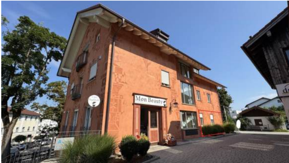
04 Ostfassade inkl. Hauszugang (EG) mit Markierung der Bewertungswohnung
