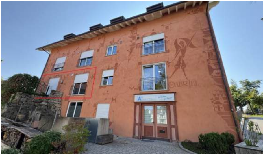
06 Westfassade inkl. Zugang zu Gewerbeeinheit KG mit Markierung der Bewertungswohnung
