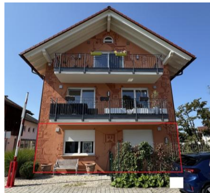
Nordfassade mit Markierung der Bewertungswohnung
