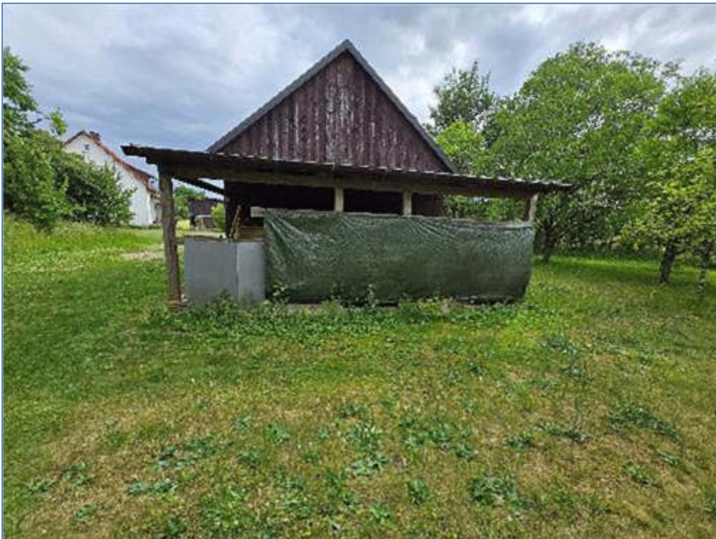
Bild 2 BBT Geräteschuppen, Nordseite
