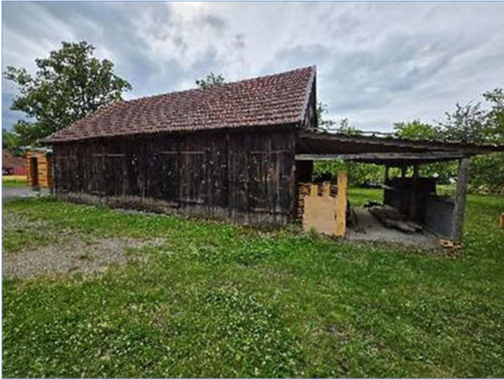
Bild 1 BBT Geräteschuppen, Ostseite
