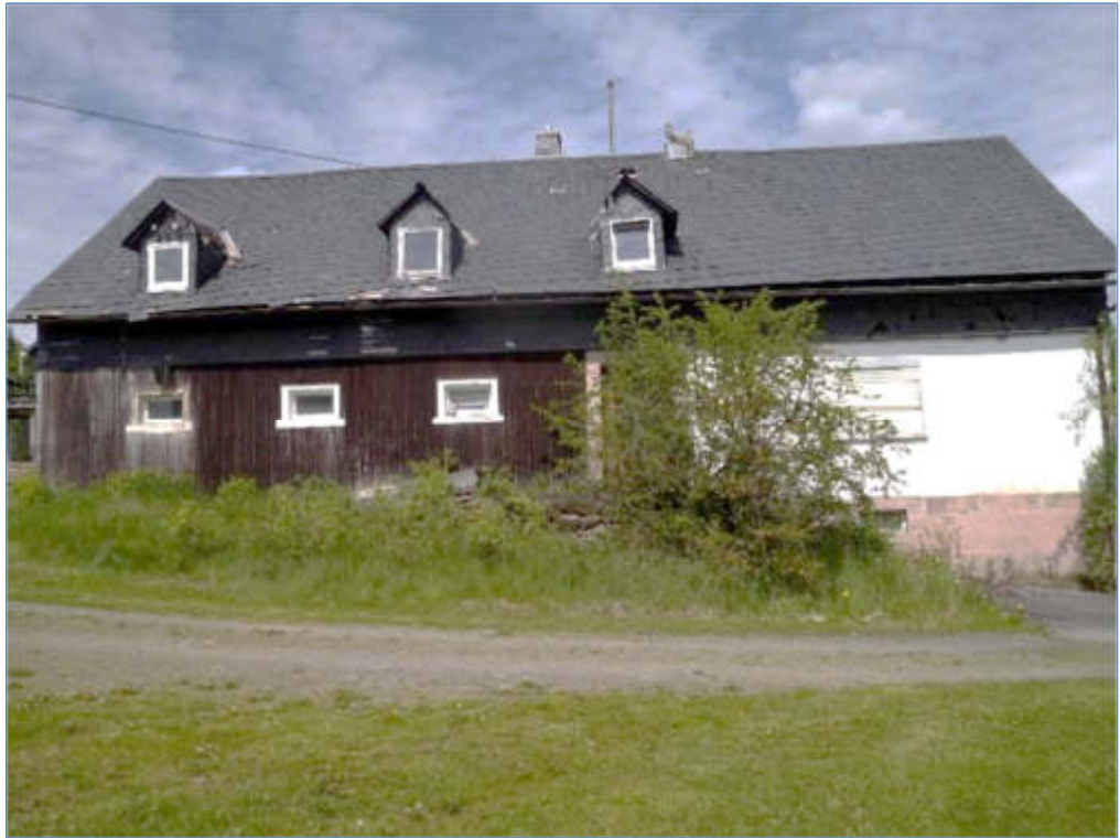
Bild 1 Pos. 01 Wohnhaus, Südseite
