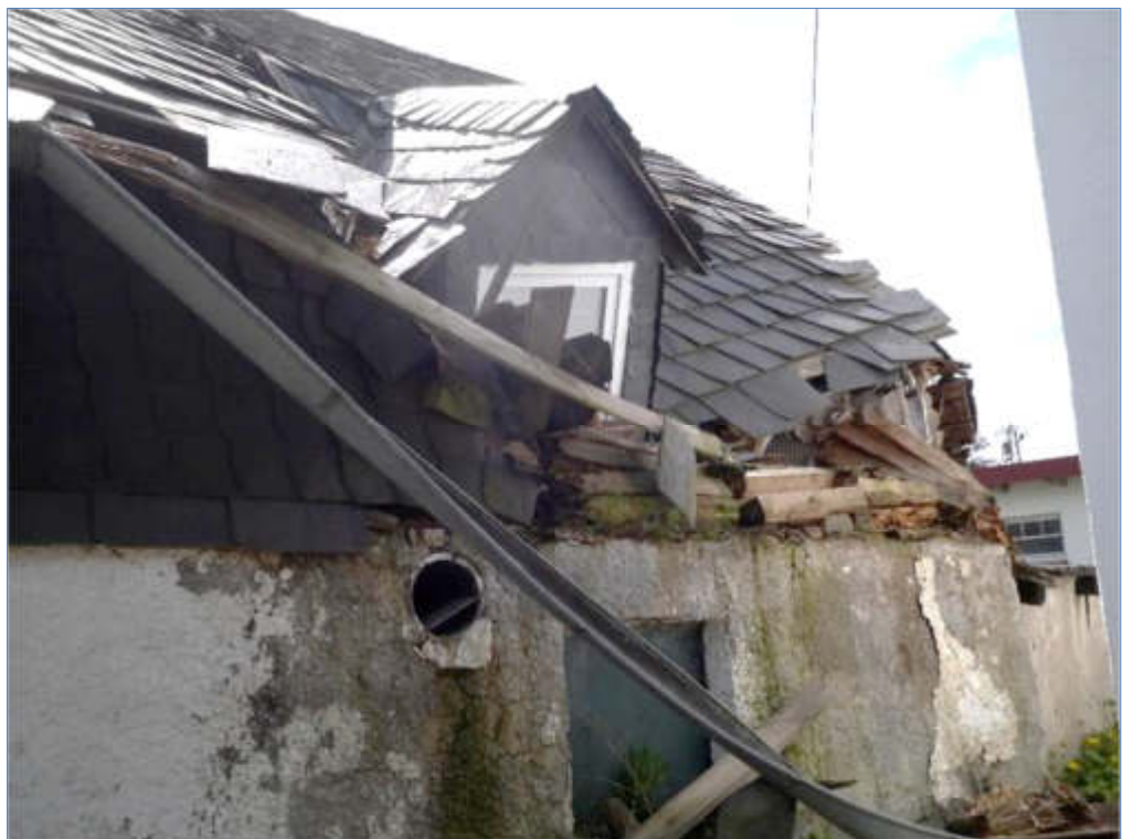
Bild 6 Pos. 01 Wohnhaus, Nordseite
