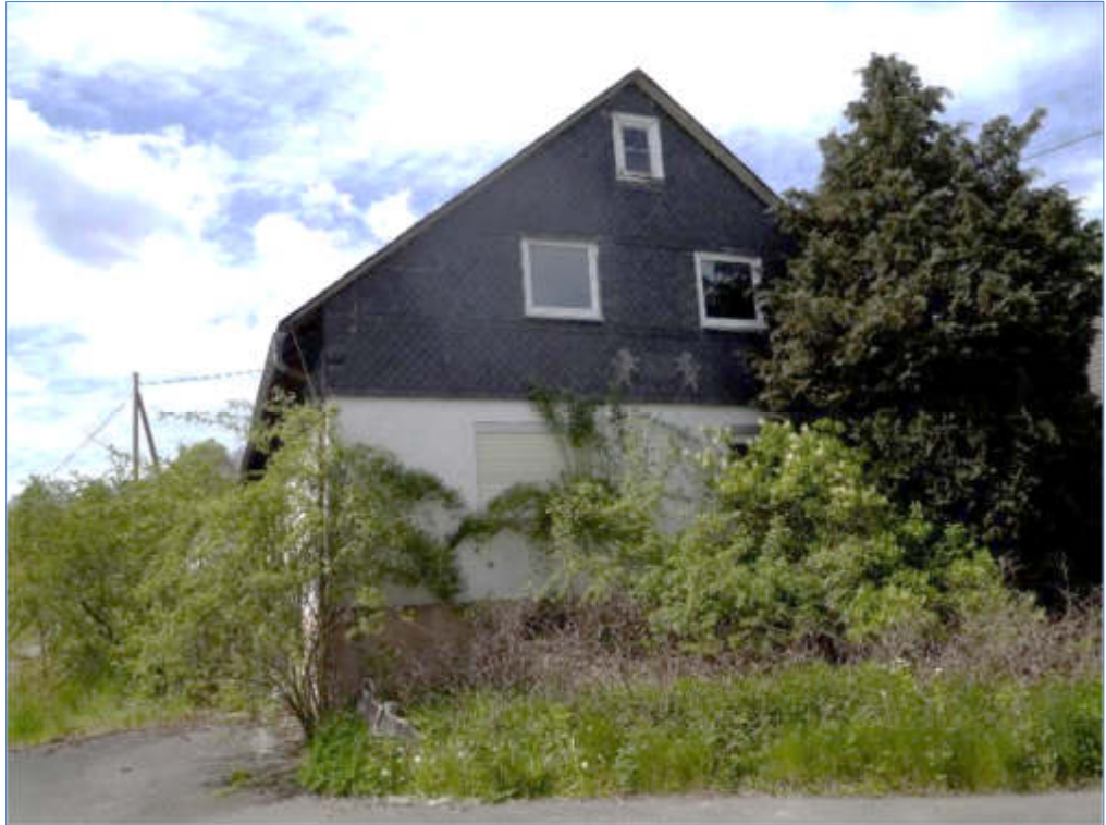
Bild 3 Pos. 01 Wohnhaus, Ostseite
