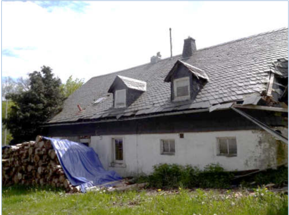
Bild 4 Pos. 01 Wohnhaus, Nordseite
