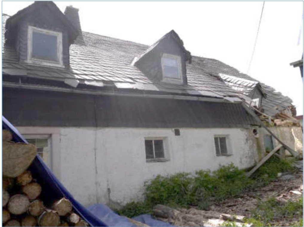
Bild 5 Pos. 01 Wohnhaus, Ausschnitt Nordseite
