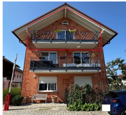
Nordfassade mit Markierung der Bewertungswohnung
