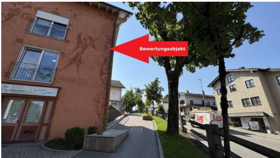
02 Straße Richtung Südost mit Markierung des Bewertungsobjekts
