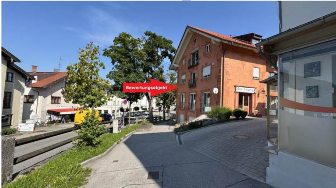
01 Straße Richtung Nordwest mit Markierung des Bewertungsobjekts
