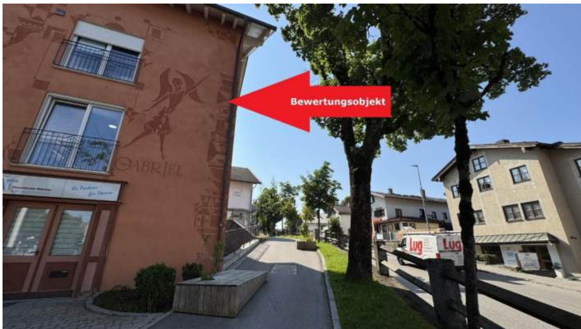
02 Straße Richtung Südost mit Markierung des Bewertungsobjekts
