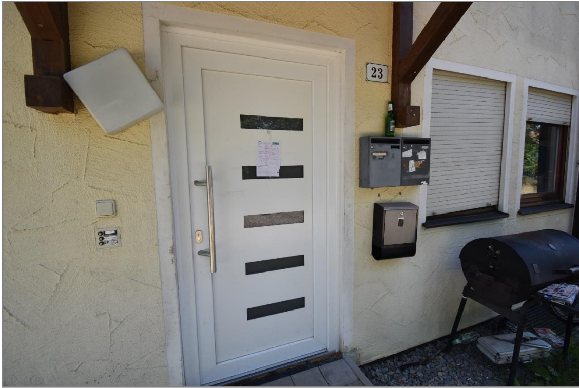
Pfarrer-Kneipp-Straße 23, Hauseingang an der Nordseite
