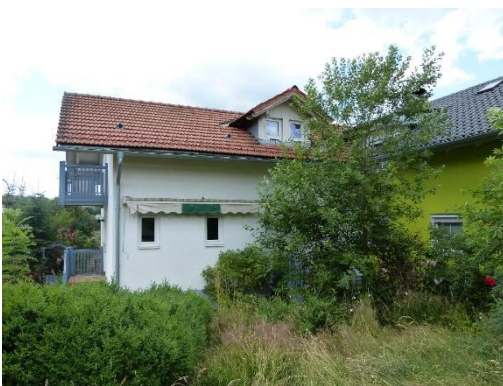
Gebäude 1: Einfamilienhausanbau, Ansicht von Osten
