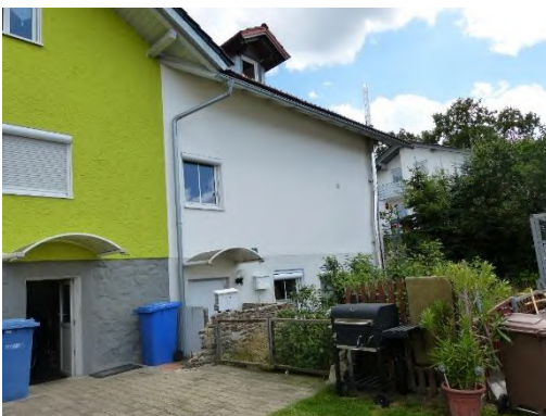
Gebäude 1: Einfamilienhausanbau, Ansicht von Nordwesten
