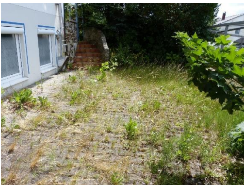
Außenanlagen, Stellplatz nach Osten
