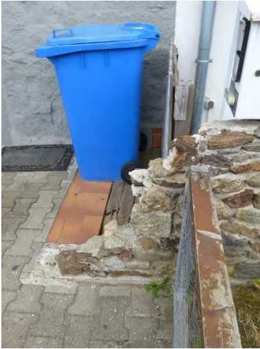
Gebäude 1: Einfamilienhausanbau, überbauter Außentreppe mit Brüstungsmauer
