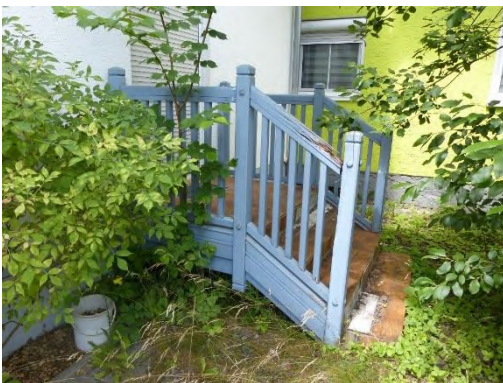
Außenanlagen, Außentreppe vom Wohnraum zum Garten
