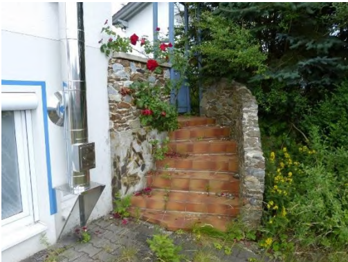
Außenanlagen, Außentreppe zum Hauseingang im Erdgeschoss
