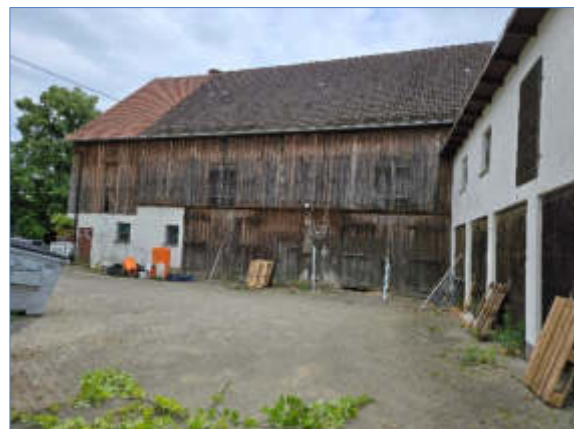
ehemalige Scheune / Garagengebäude / Backofen
