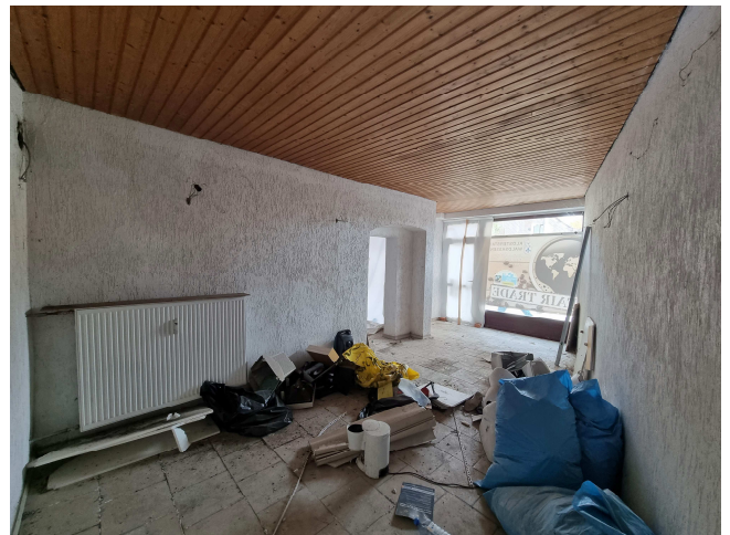
Raum 1 (= Raum SO-Ecke, mit Ladentür) Laden Nr. 1 im Hauptgebäude - EG
