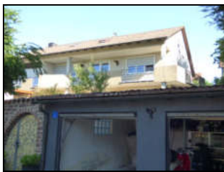
Ansicht ZFH von Südosten (Zufahrtbereich)
