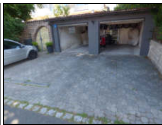
Ansicht Do.-Garage von Südosten (Zufahrtbereich)
