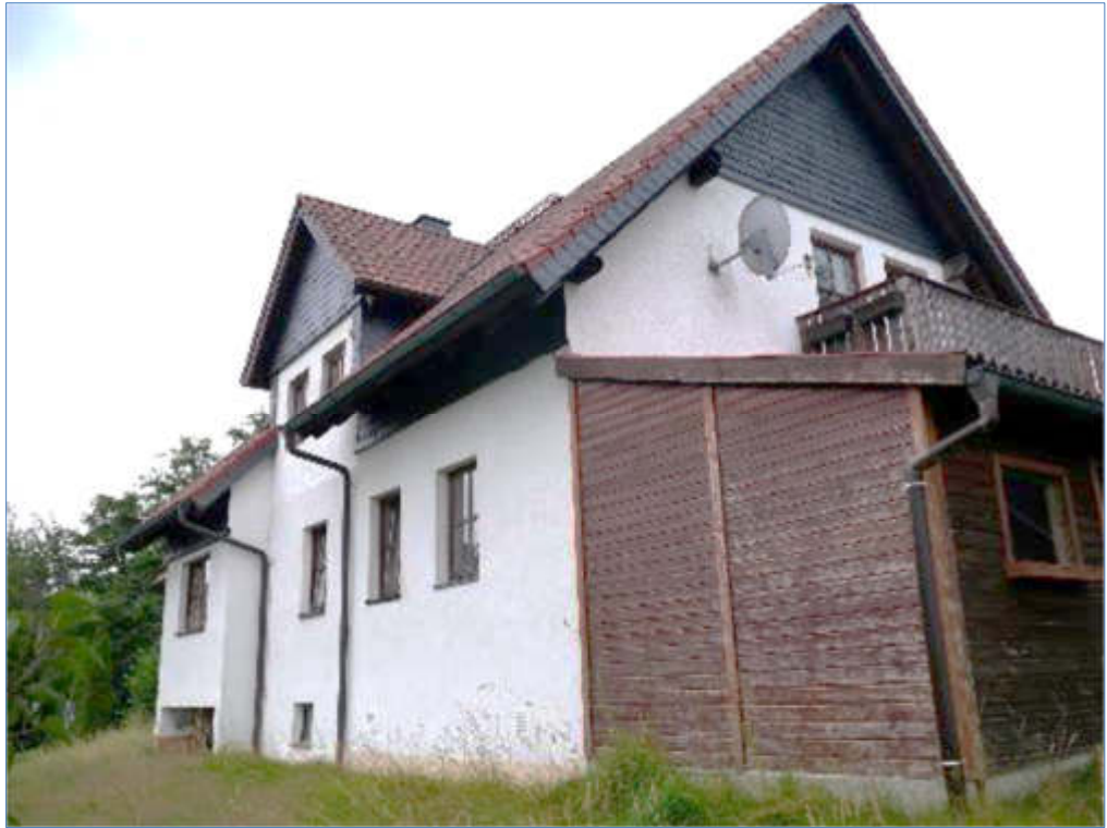
Bild 1 Pos. 01 Wohnhaus und BBT Holzschuppen, Nordseite
