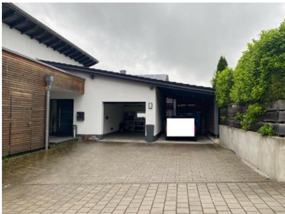
Ostansicht Garage und Carport
