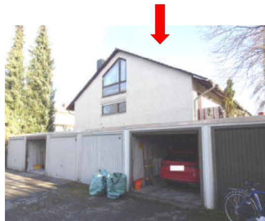
Nordwestseite des Reihenhauses
