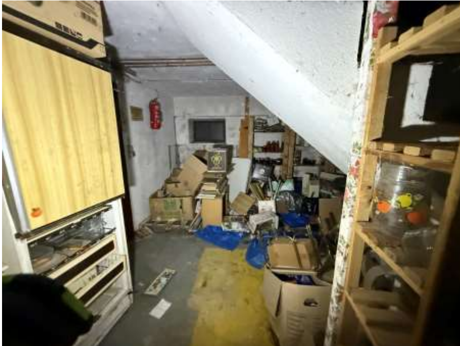
Bild 27: KG, Kellerraum, Zugang zum Heizungsraum
