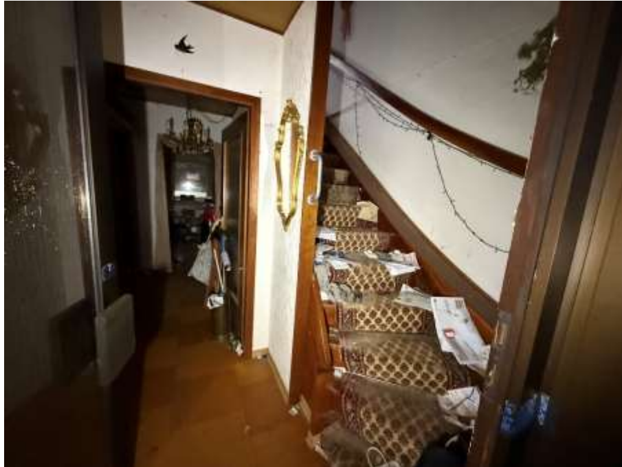
Bild 15: Windfang, Treppe EG
