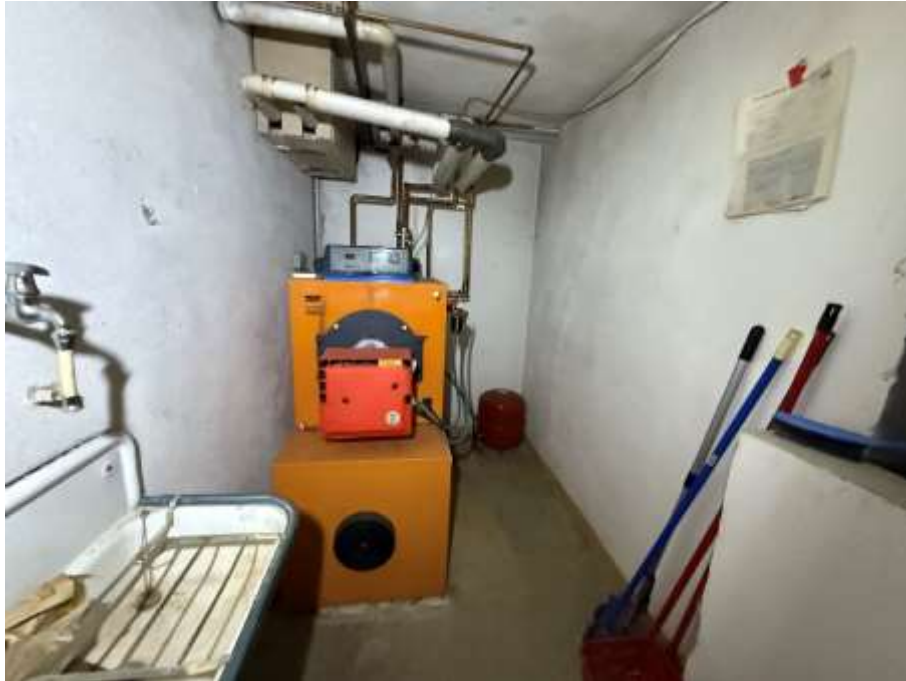
Bild 29: KG, Ölzentral-Heizung
