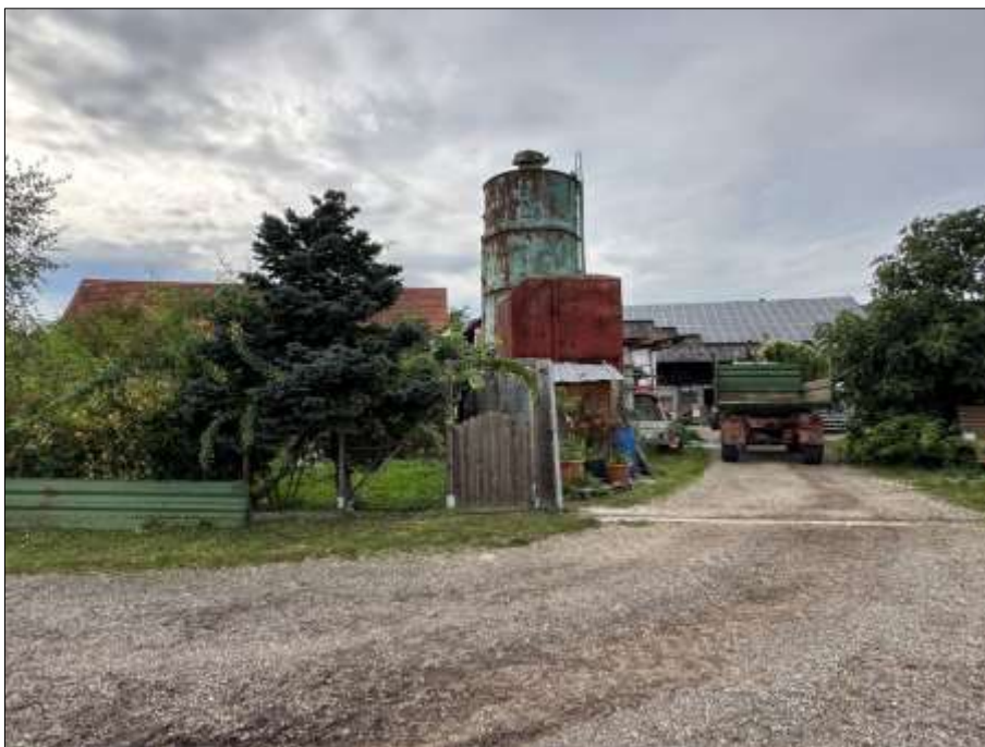
Bild 12: Blick zur Nachbarbebauung
