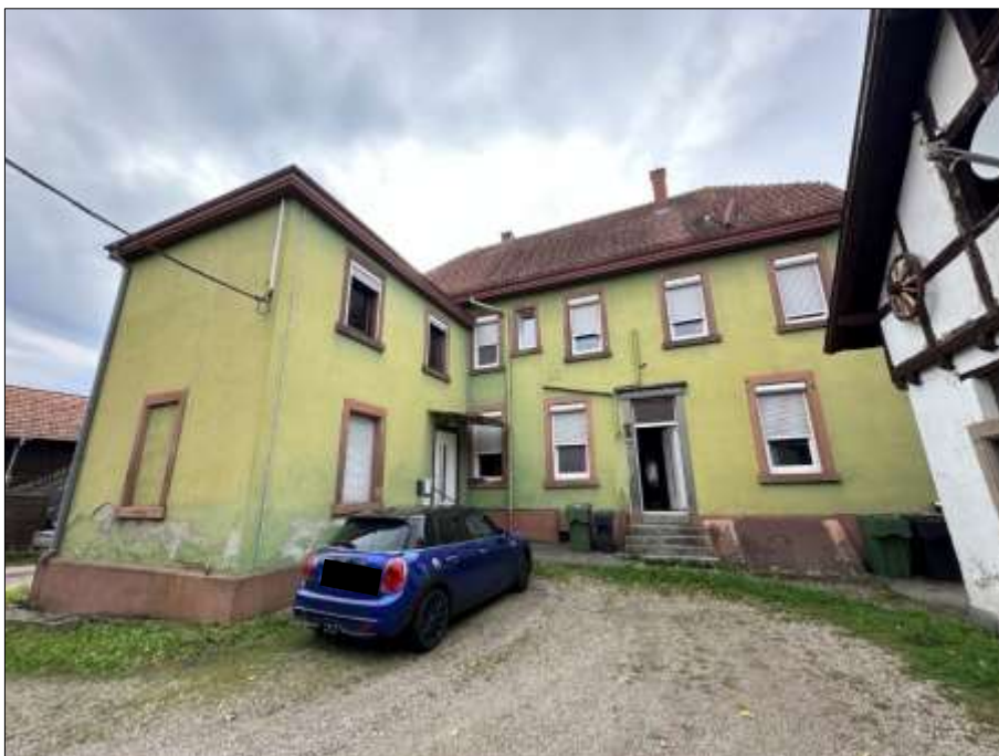
Bild 6: Wohnhaus, Ostfassade, Hof
