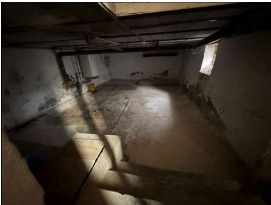
Bild 24: KG, Kellertreppe, Kellerraum
