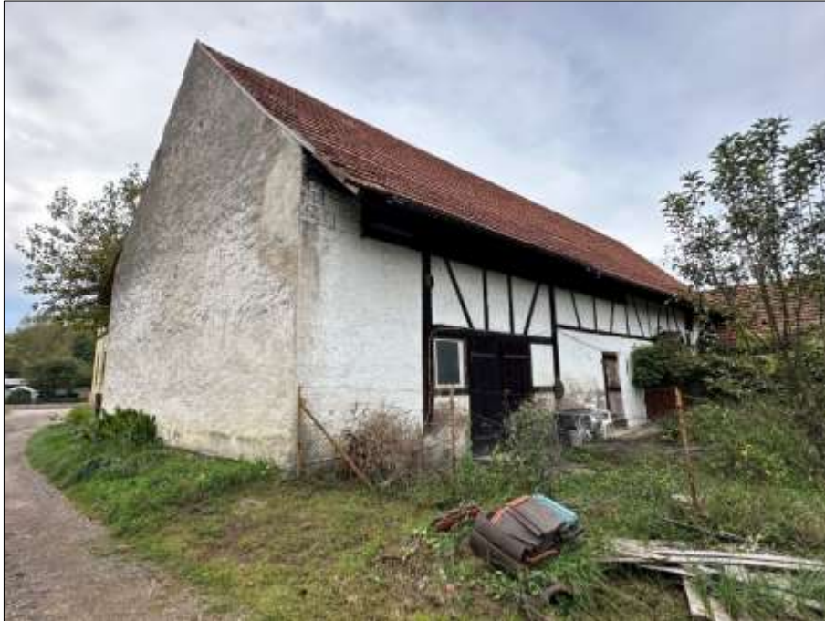
Bild 11: Ökonomiegebäude, Süd-/ Ostfassade
