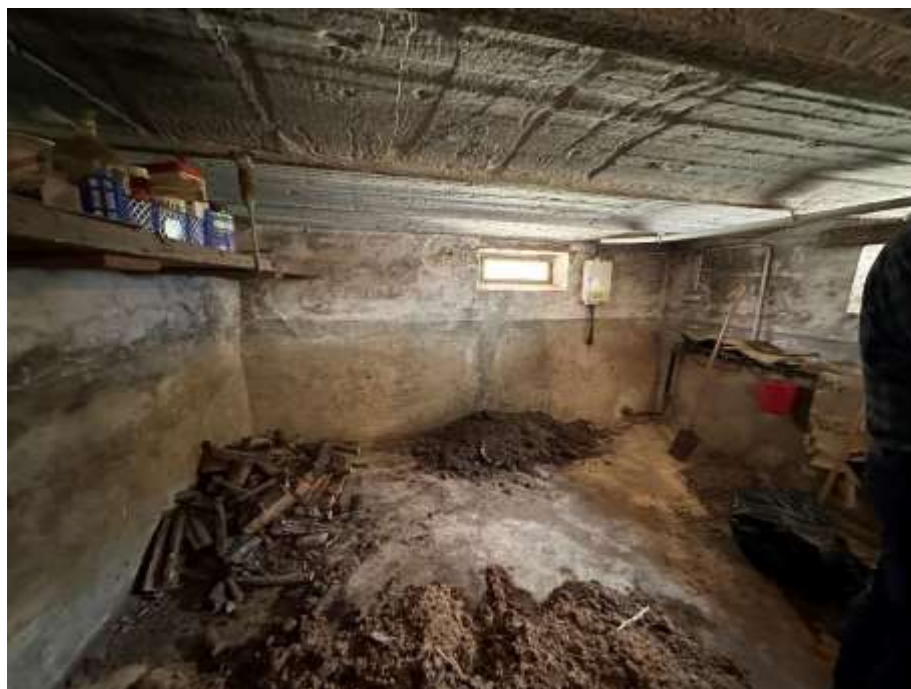
Bild 20: KG, Anbau, Lagerkeller
