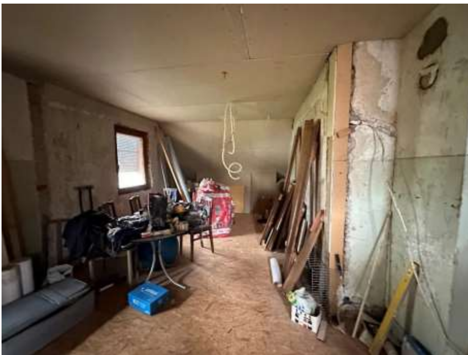
Bild 24: DG, Giebelzimmer, rudimentärer Ausbau
