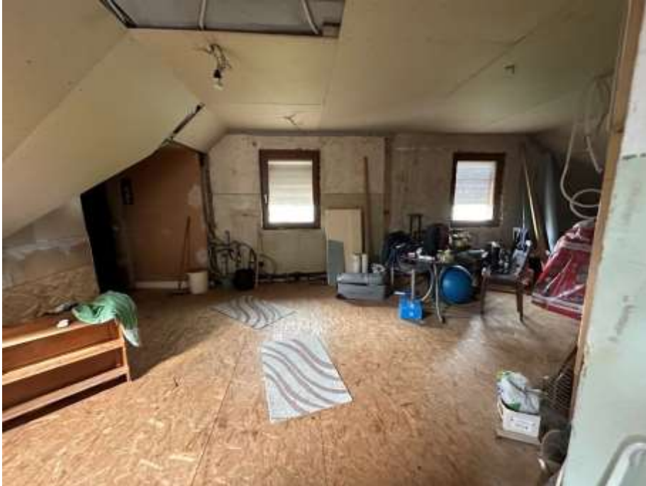
Bild 23: DG, Giebelzimmer, rudimentärer Ausbau
