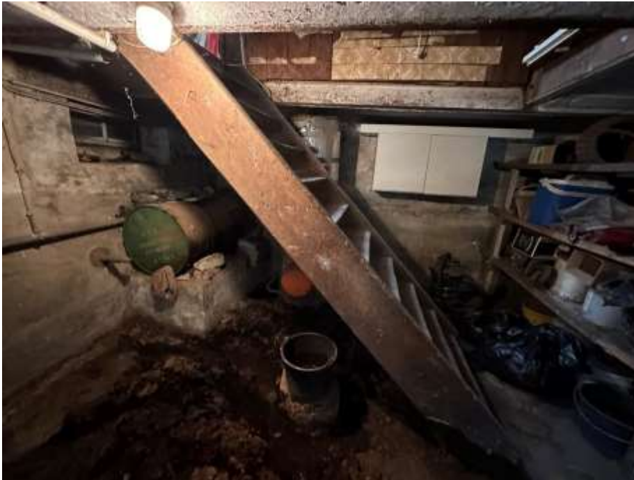
Bild 19: KG, Anbau, Stiege zum Kellergeschoss
