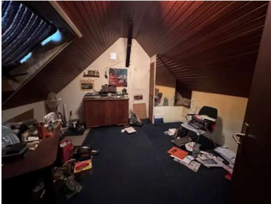
Bild 25: DG, Giebelzimmer, rudimentärer Ausbau
