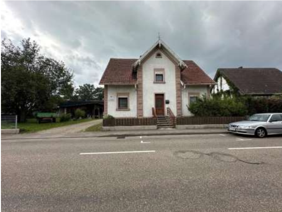
Bild 1: Wohnhaus mit Einfahrt, Ostfassade
