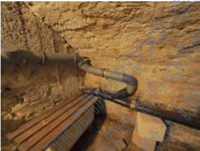
Gewölbekeller im Untergeschoss
