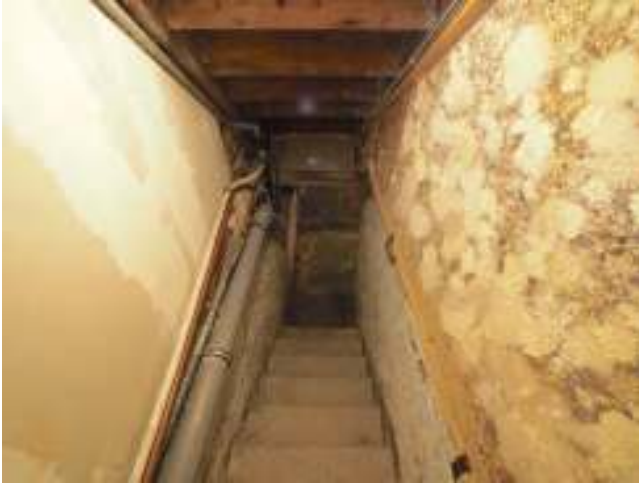
Treppe ins Untergeschoss
