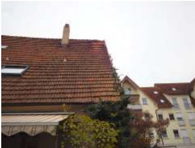
Außenansicht Dach von der Westseite
