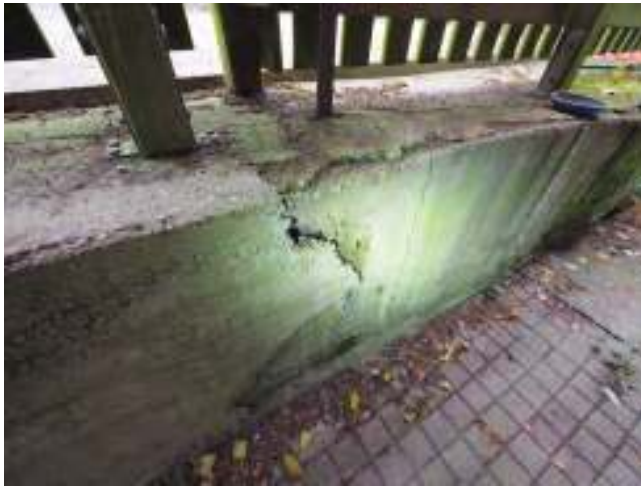
Beschädigte Stützmauer
