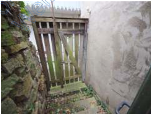
Zugang zur Rückseite (Westseite der Immobilie)
