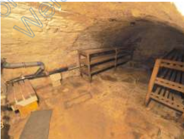
Gewölbekeller im Untergeschoss
