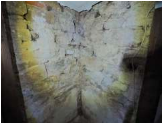
Offenes Mauerwerk Gewerbeeinheit EG links
