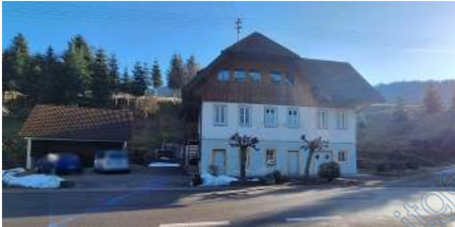
Ansicht von West
