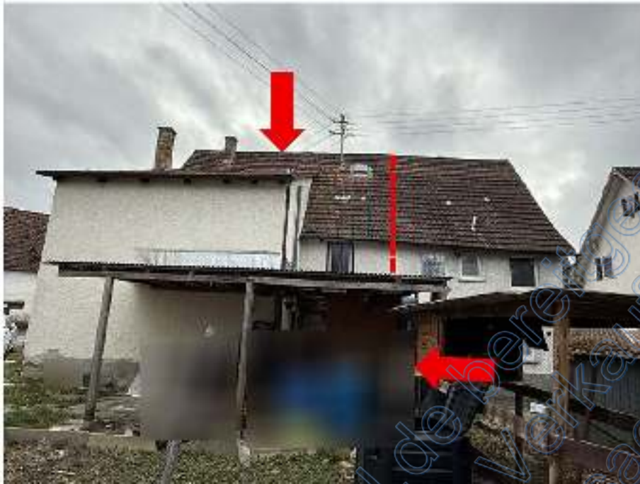
Bild 3 Anbauten in Leichtbauweise
