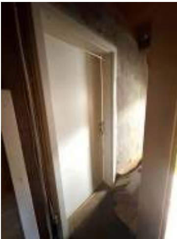
(65) Zugang zur Dachkammer nur über Bühne
