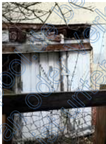
(36) Dito Detail Holzwerk muss statisch überprüft werden
