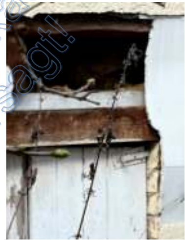
(50) Dito Detail Holzgefache der Holzbalkendecke über UG z. T. offen
