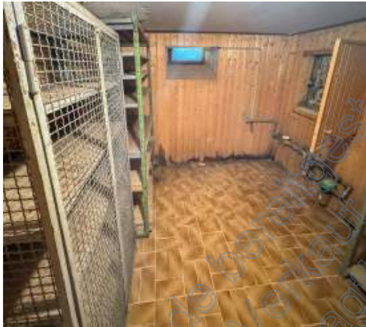
Bild 15: Teilunterkellerung mit verkleideten Außenwänden
