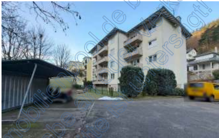
Ansicht Nord- und Ostfassade Bewertungsobjekt
