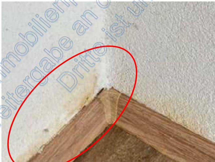
Bild 10: Beispiel mangelhaft ausgeführter Putzarbeiten Wohnung Nr. 1
