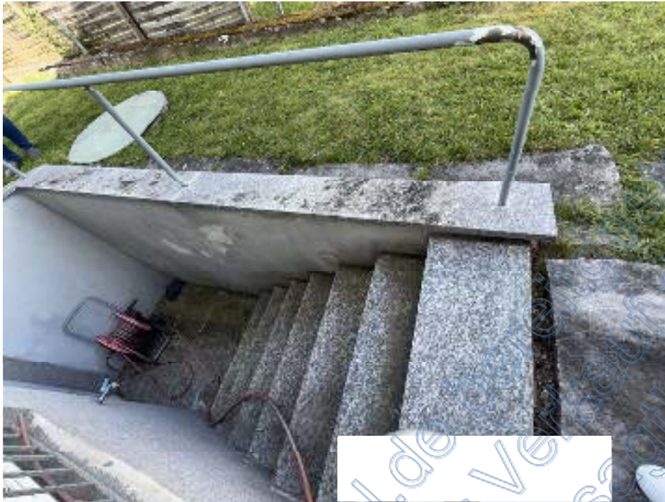
Bild 10 Kelleraußentreppe und Schacht für Ölaufentank
