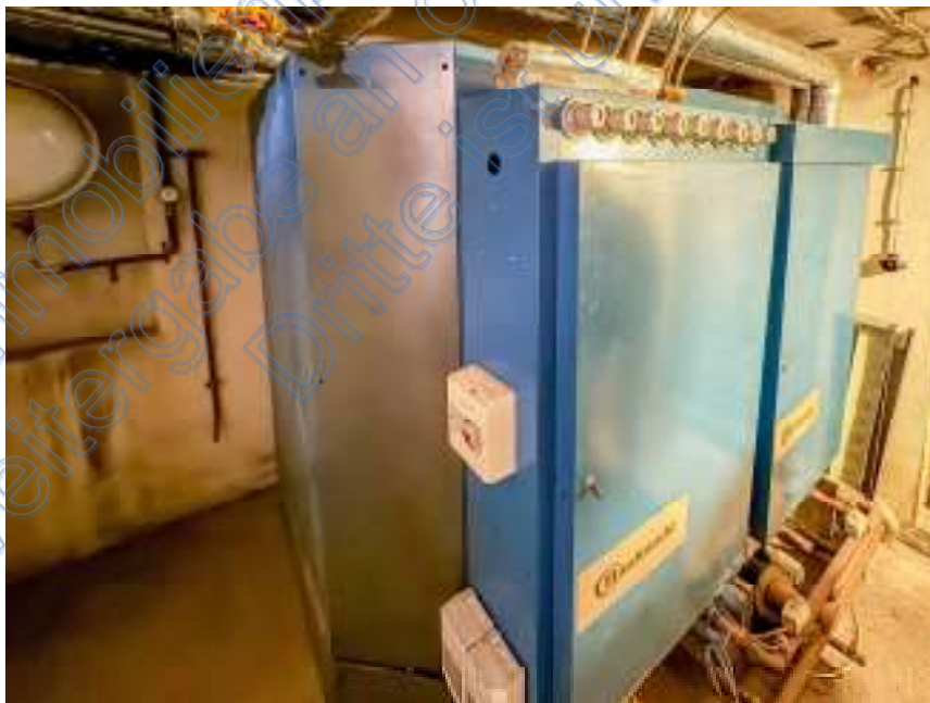
Bild 34: Blockheizkraftwerk im KG
