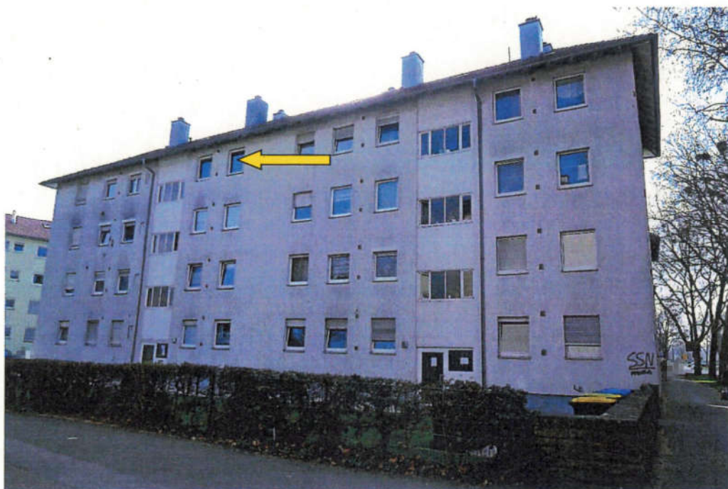
Nordostansicht des Wohnhauses. Der gelbe Pfeil zeigt auf das Fenster der Küche.
