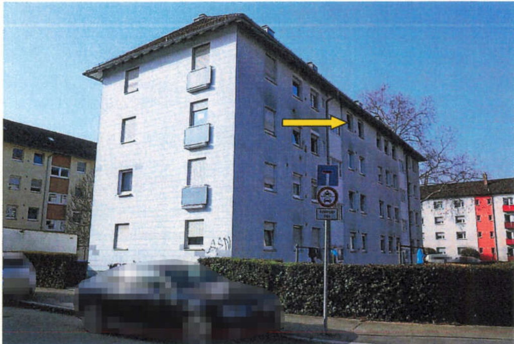
Blick auf das Reihenwohnhaus von Südosten. Der gelbe Pfeil zeigt auf das Fenster des Bades.
