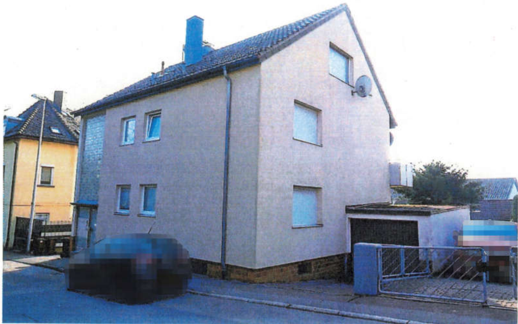
Blick auf das Wohngebäude aus Richtung Westen.
