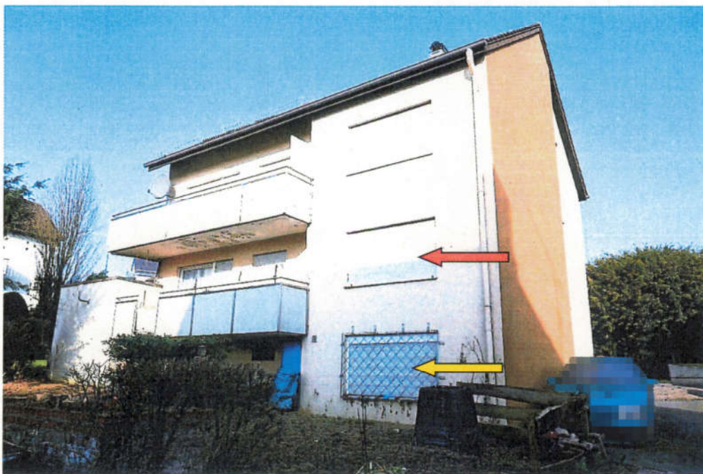
Rückansicht des 5-Familien-Wohnhauses von Osten. Der gelbe Pfeil zeigt auf das Fenster des Hobbyraumes. Der rote Pfeil zeigt auf das Wohn-/Schlafzimmerfenster der zu bewertenden Wohnung Nr. 2 im Erdgeschoss.
