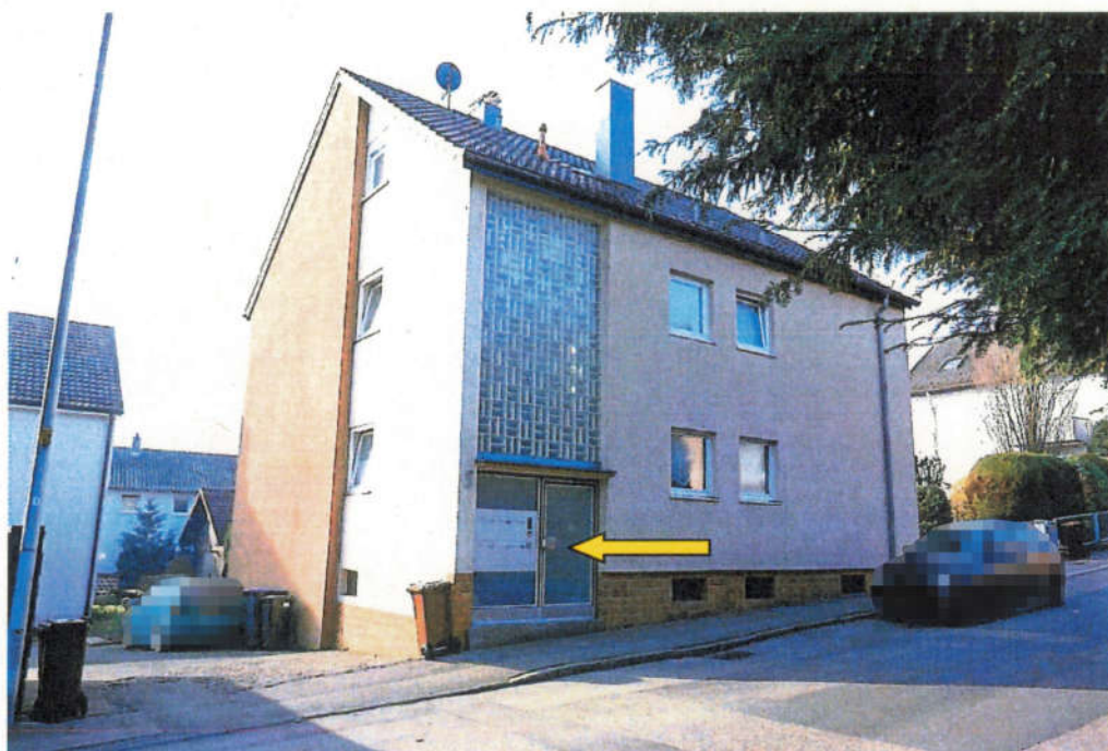
Blick auf das Mehrfamilienwohnhaus von Norden. Der gelbe Pfeil zeigt auf den Zugang zum Treppenhaus des Wohngebäudes.
