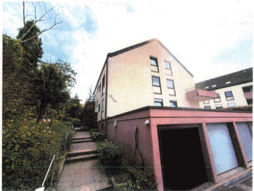
Foto 3 des SV: Ansicht v. Westen; Zugang zur Tscherningstraße 12/14
