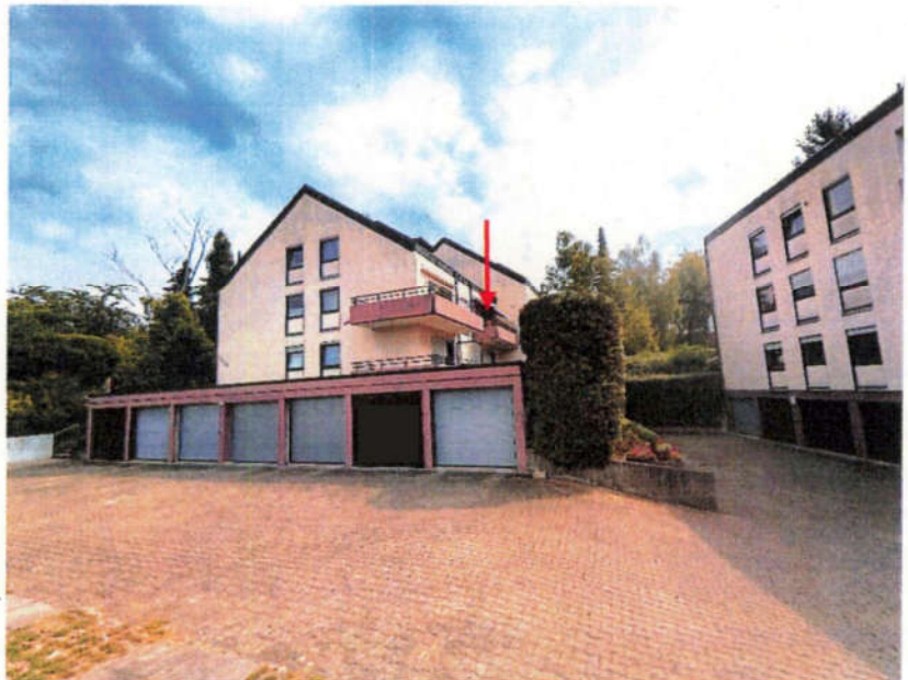
Foto 2 des SV: Ansicht von Südwesten, Tscherningstraße 12/14; Detail: Lage der Wohnung Nr. 29
