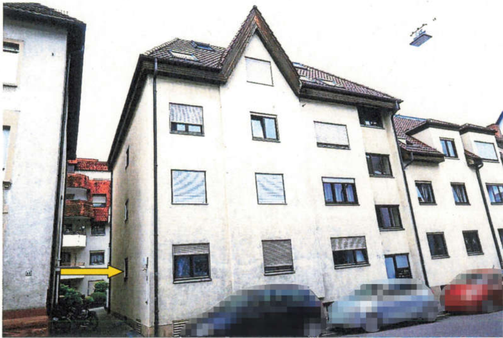
Blick von Osten auf das Wohnhaus Mönchseestr. 73 auf dem Flst. Nr. 4300. Der gelbe Pfeil zeigt auf das Fenster der Küche. Links und rechts des Gebäudes befinden sich die Flurstücke 4301 und 4302.
