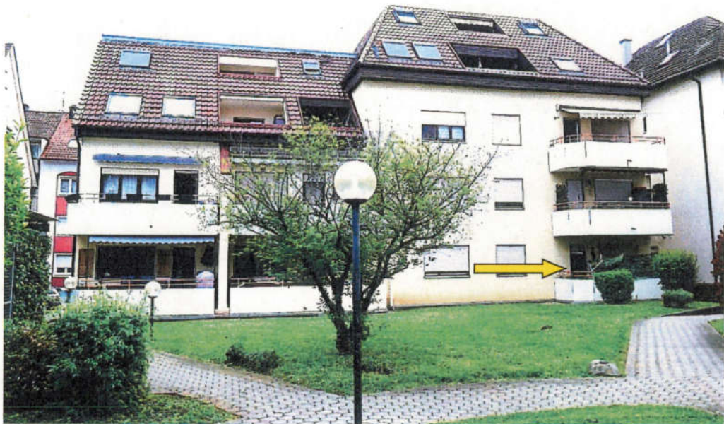
Rückansicht des Gebäudes Nr. 73 von Westen. Der gelbe Pfeil zeigt auf den Balkon der zu bewertenden Wohnung Nr. 3 im Erdgeschoss.
