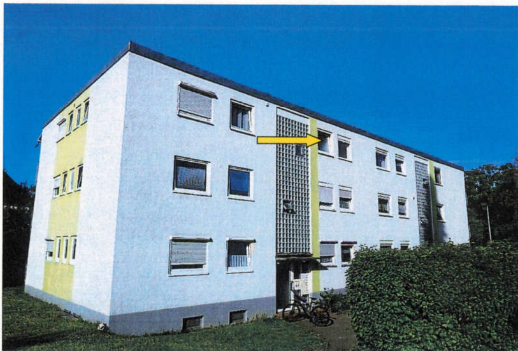
Blick auf das Wohnhaus Nr. 44/2 von Osten. Der gelbe Pfeil zeigt auf das Badfenster. Rechts daneben befindet sich das Fenster der Küche.
