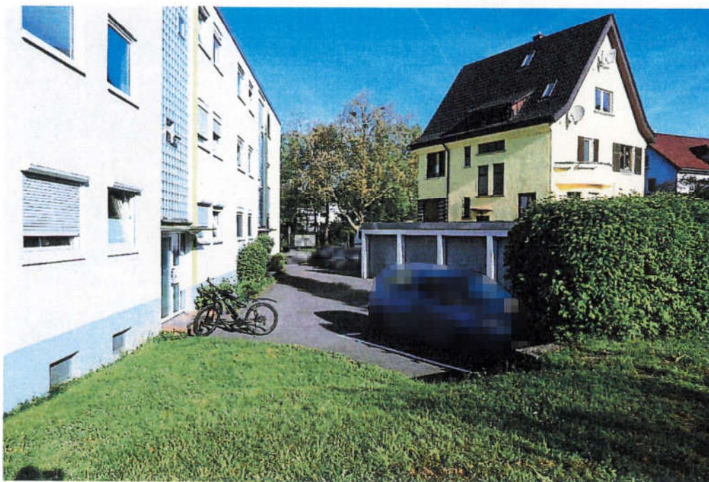
Blick auf die nördlichen Freiflächen mit Garagenkomplex.
