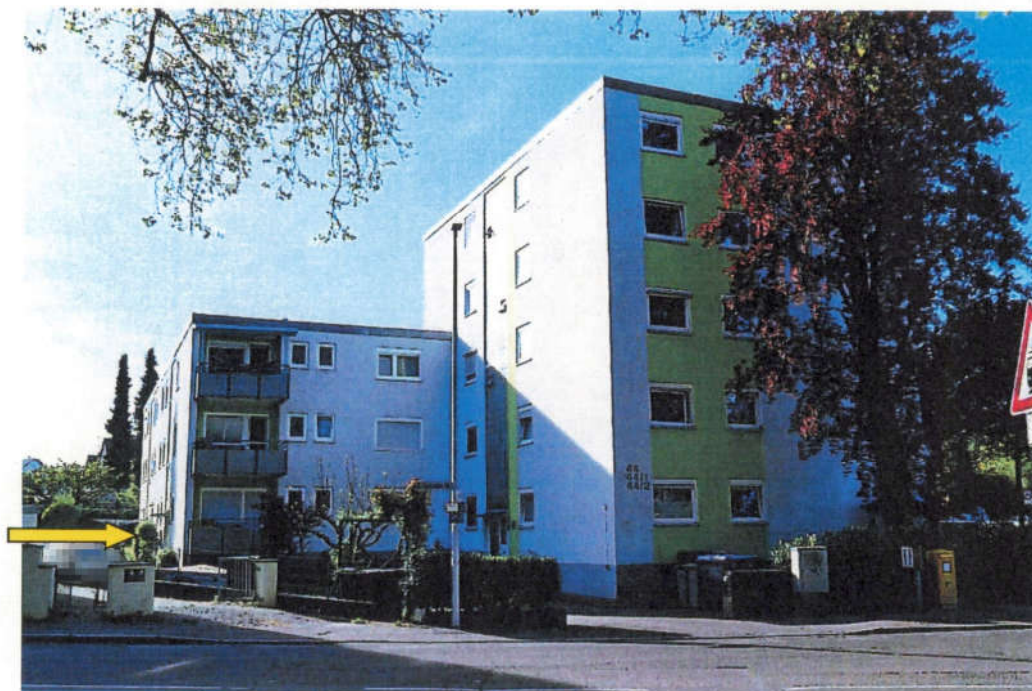
Blick auf die Wohngebäude Nr. 44, 44/1 und 44/2 von Nordwesten. Der gelbe Pfeil zeigt auf den Hauseingang zum Gebäude Nr. 44/2.
