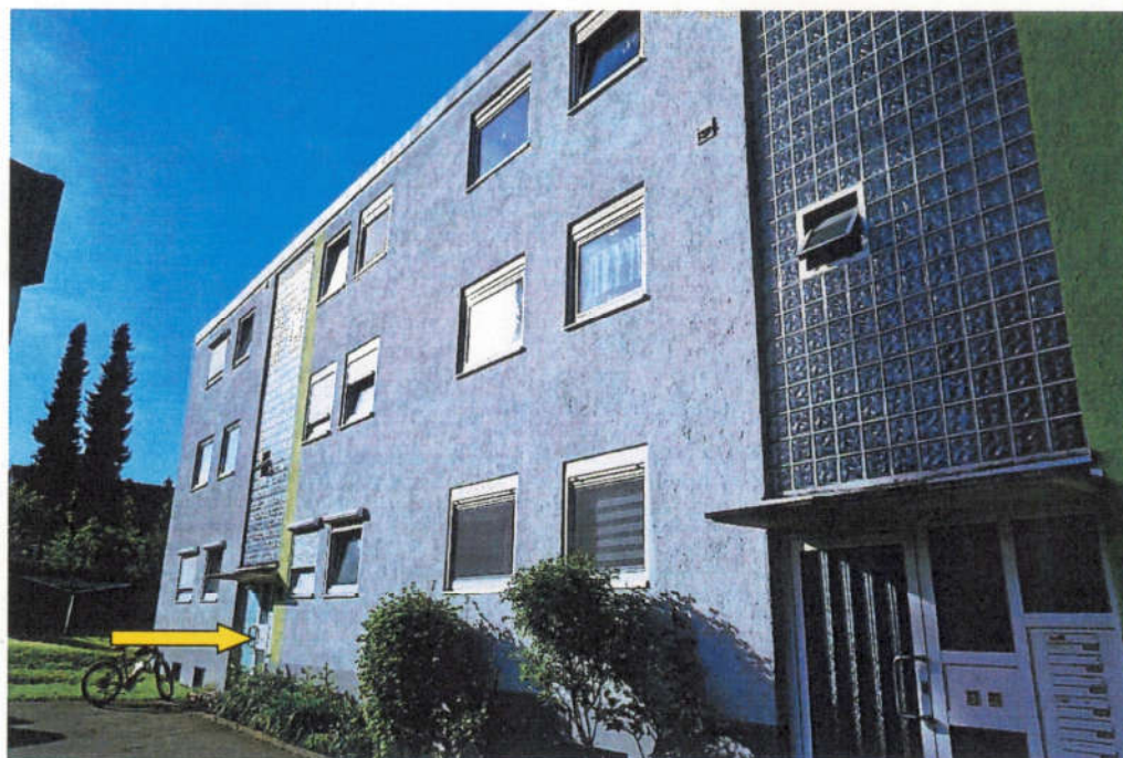
Nordwestansicht des Wohnhauses. Der gelbe Pfeil zeigt auf den Hauseingang.
