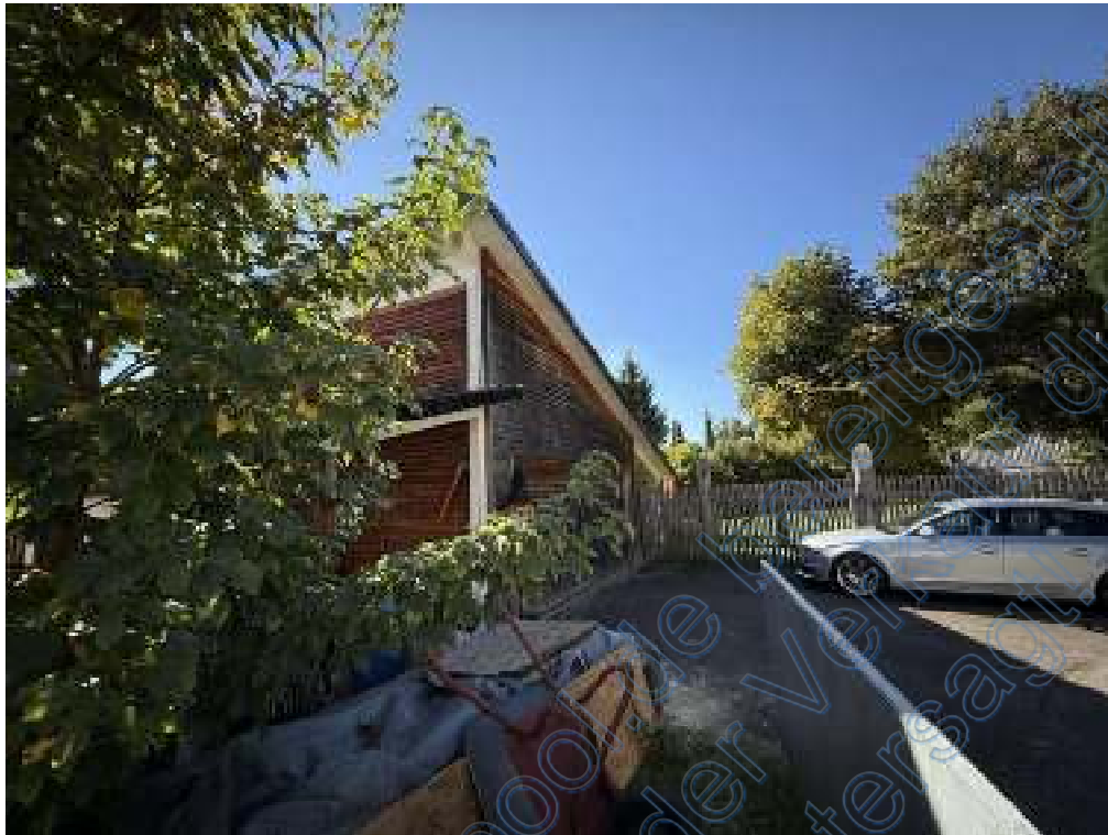
Bild 5 Ansicht Ost – überdachte Fertigteilgaragen mit laut Baugenehmigungsplan Carports links und rechts
