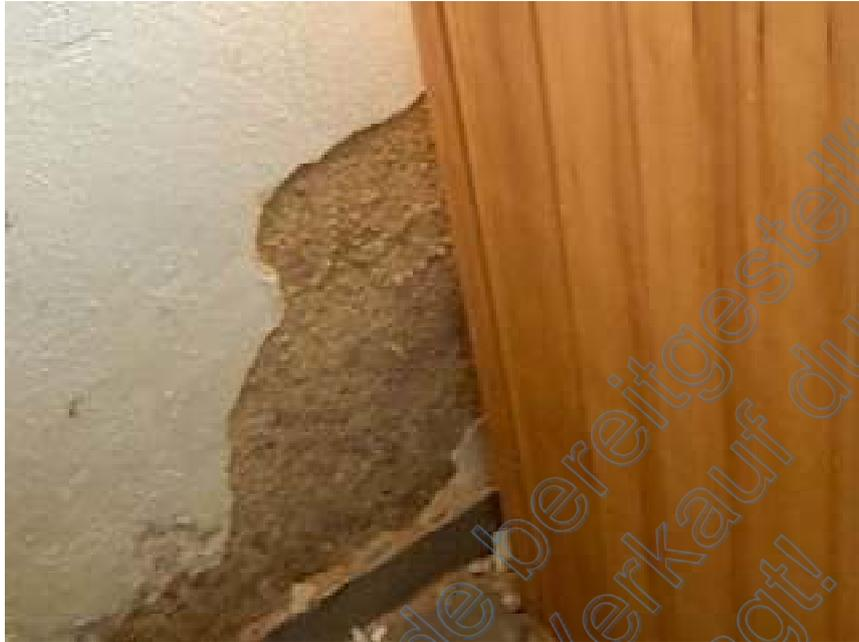
Bild 23: Beispiel Feuchtigkeitsschäden im Keller
