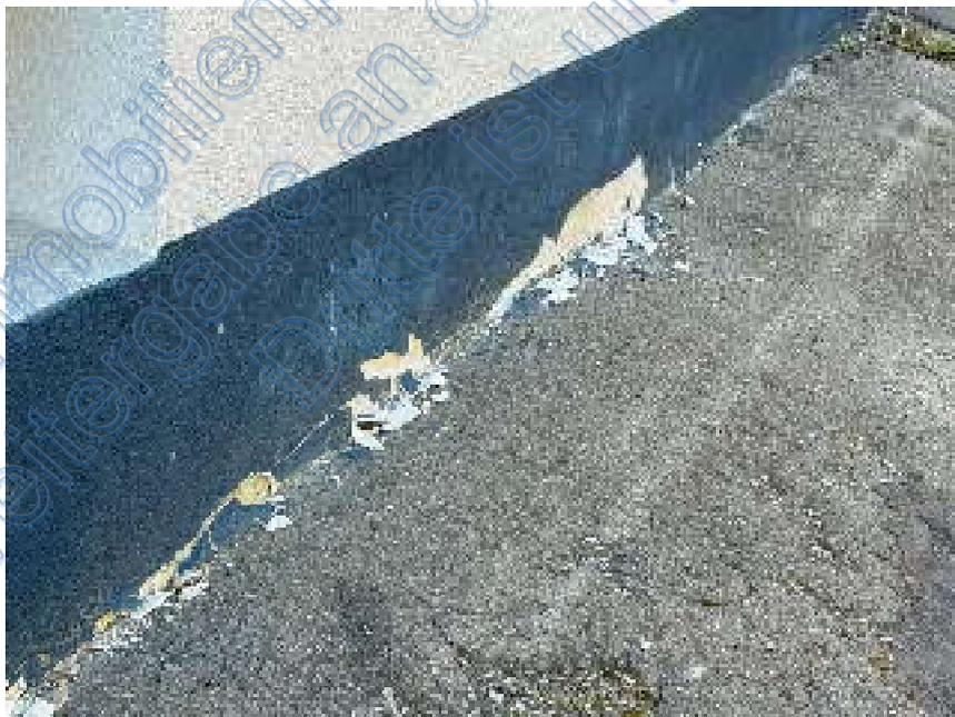
Bild 22: Putzschäden im äußeren Sockelbereich
