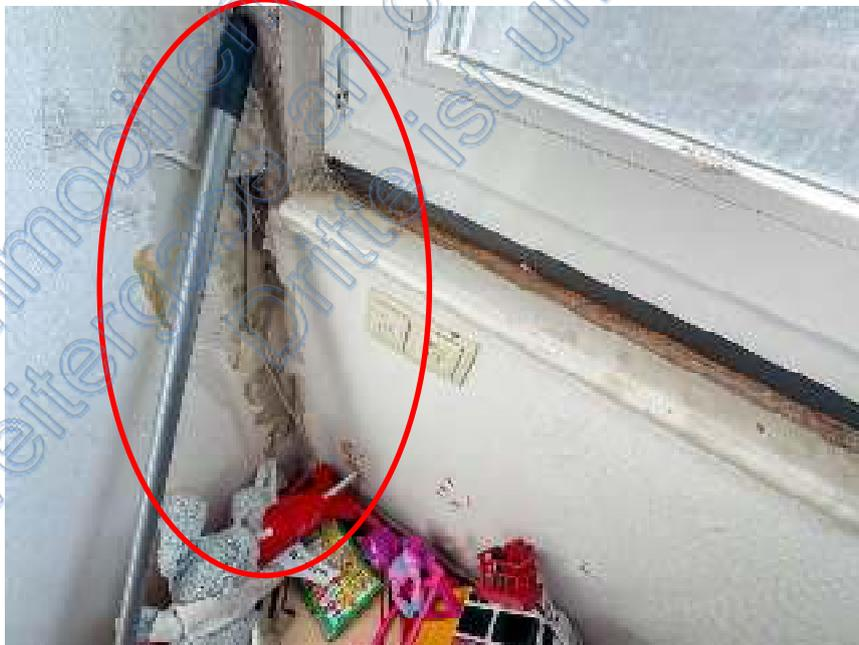
Bild 24: Beispiel offene Kabelführung
