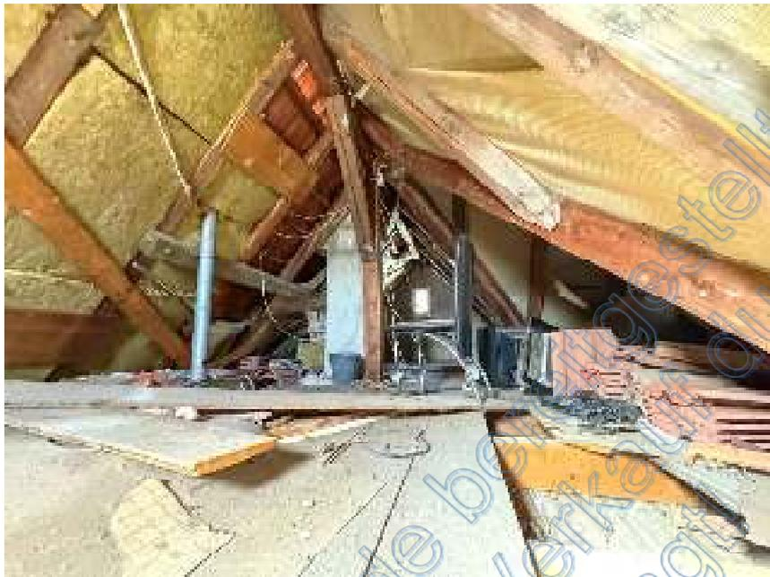
Bild 19: Dachraum, tlw. beschädigte und fehlende Dachflächendämmung
