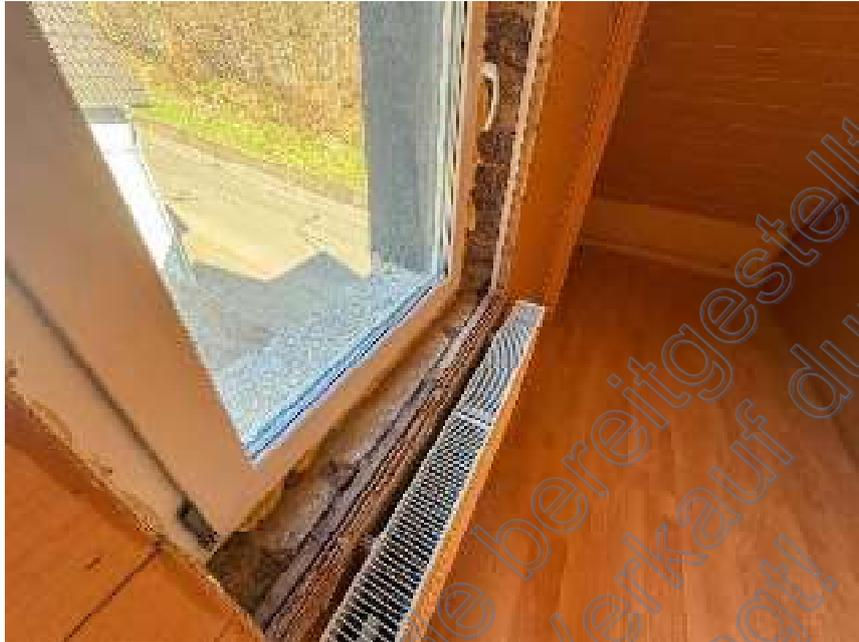
Bild 25: Beispiel fehlende Fensteranschlüsse
