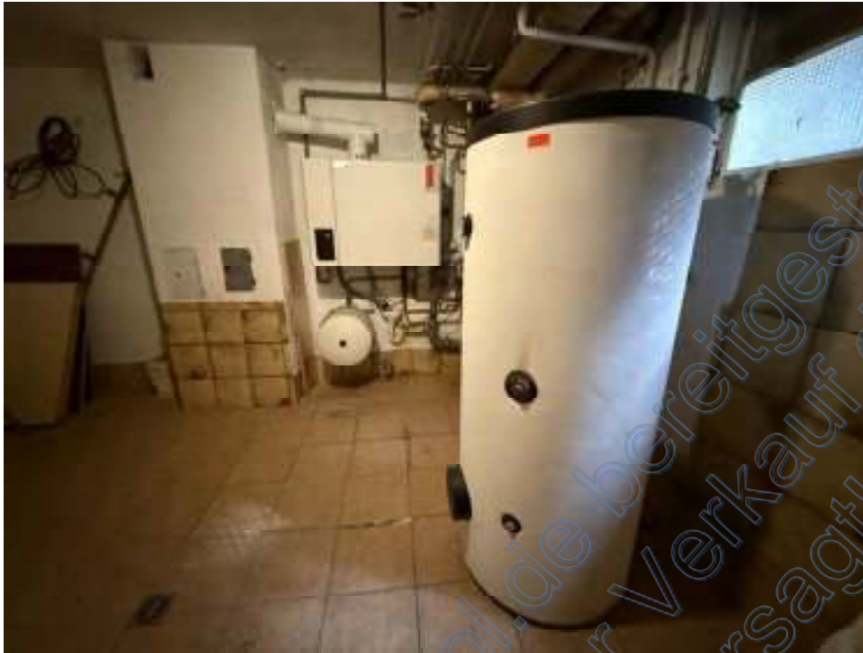
Gaszentralheizung im Untergeschoss
