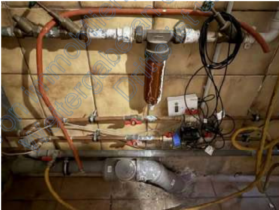
Untergeschoss – Heizungsleitungen mit Grünspan
