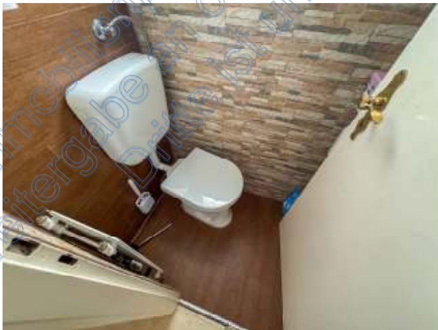
Bild 14: WC im EG
