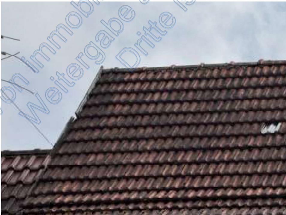
Dachdeckung Nord mit durchgefalltem Ortgangbrett
