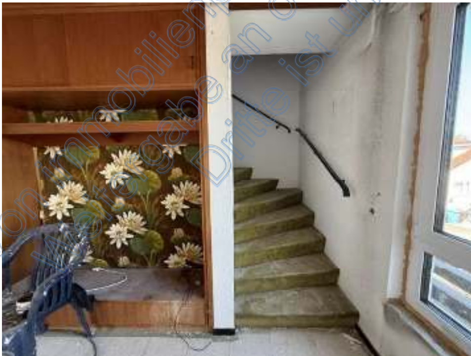
Bild 18 Aufgang ins Dachgeschoss
