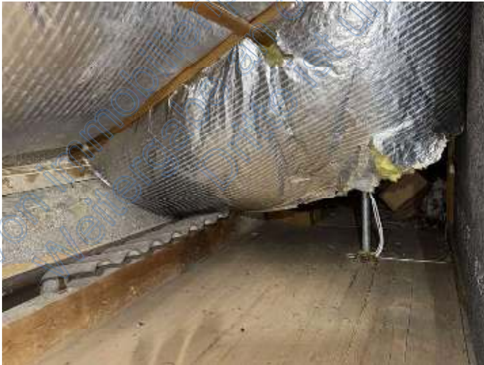
Bild 22 Dachgeschoss – Abseiten mit Wärmedämmung
