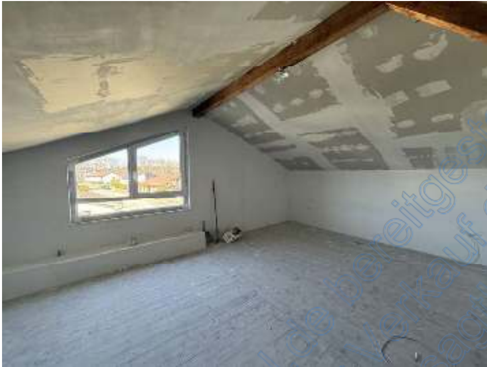
Bild 21 Dachgeschoss – weiteres Zimmer
