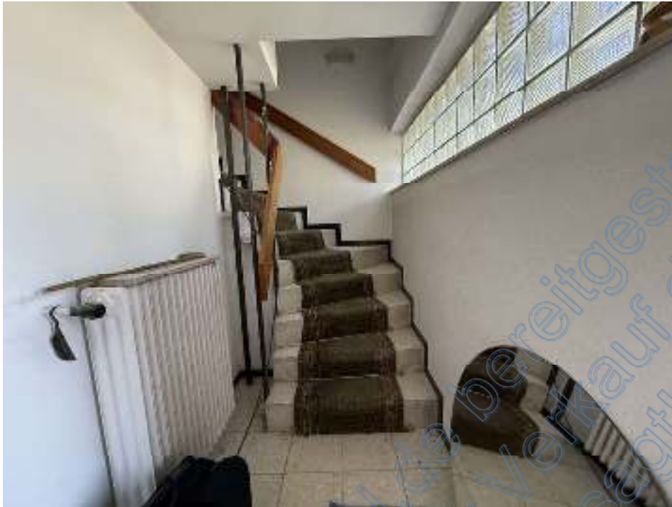
Bild 9 Treppenaufgang ins Erdgeschoss
