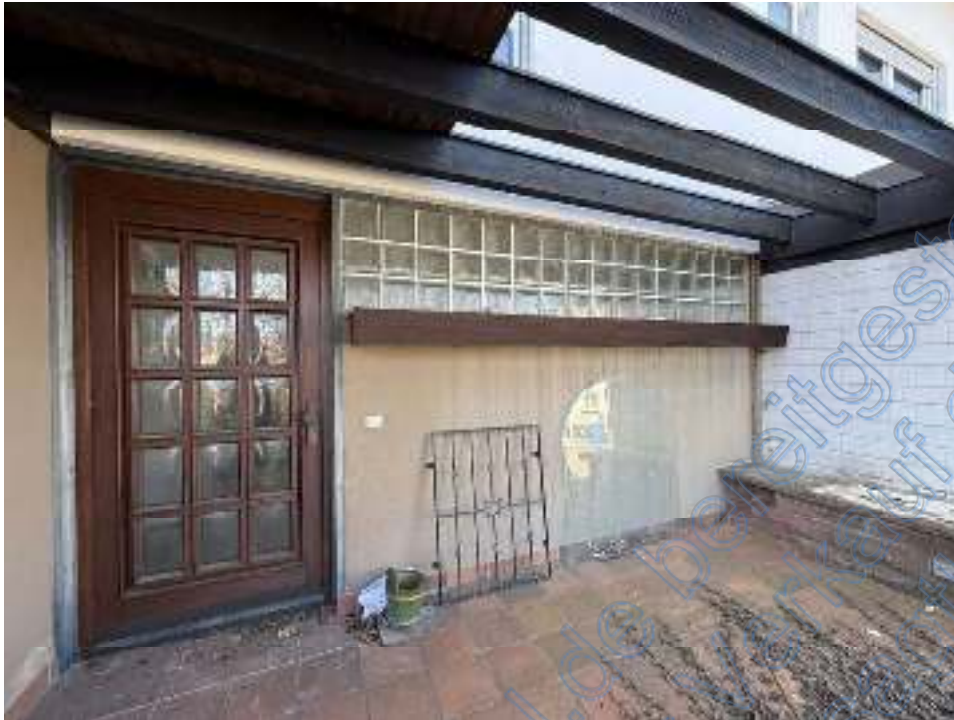
Bild 5 Hauszugang im Hanggeschoss
