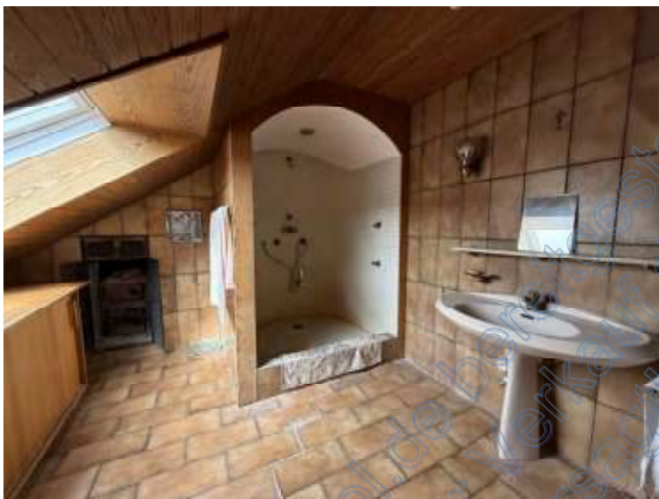
Bild 33 nicht genehmigter Ausbau des Dachgeschosses – Bad
