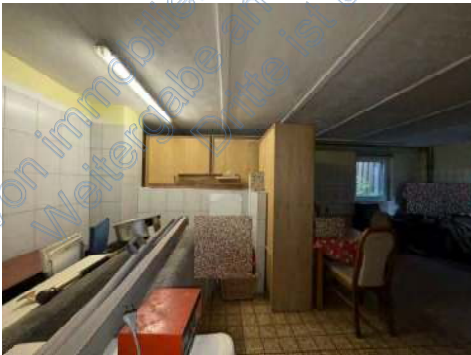
Bild 8 Untergeschoss Zugang über Eisdiele – Küche
