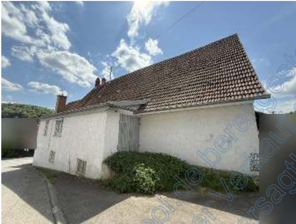
Bild 5 Ansicht Nordwest mit von außen zugänglichem Abstellraum in Erweiterung ehemaliger Stall
