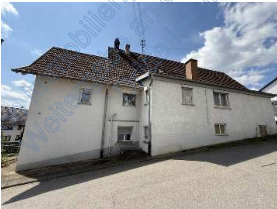
Bild 4 Ansicht Nord mit Anbau ehemaliger Stall
