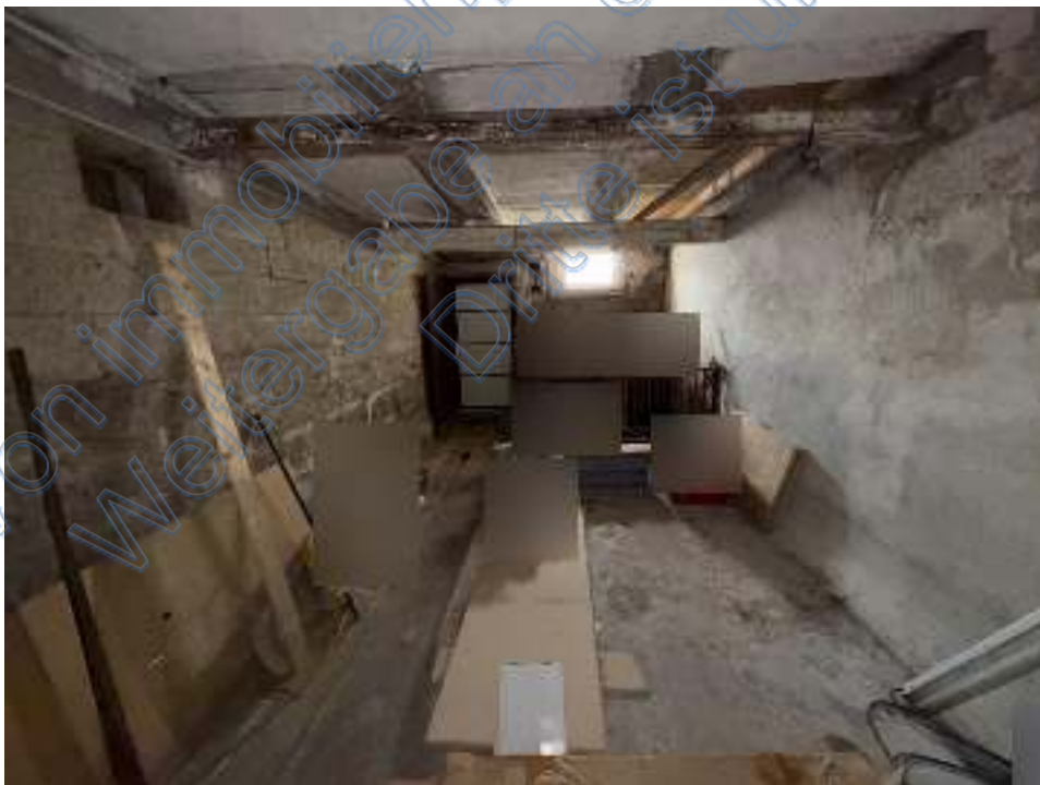
Bild 10 Erdgeschoss – ehemaliger Stall
