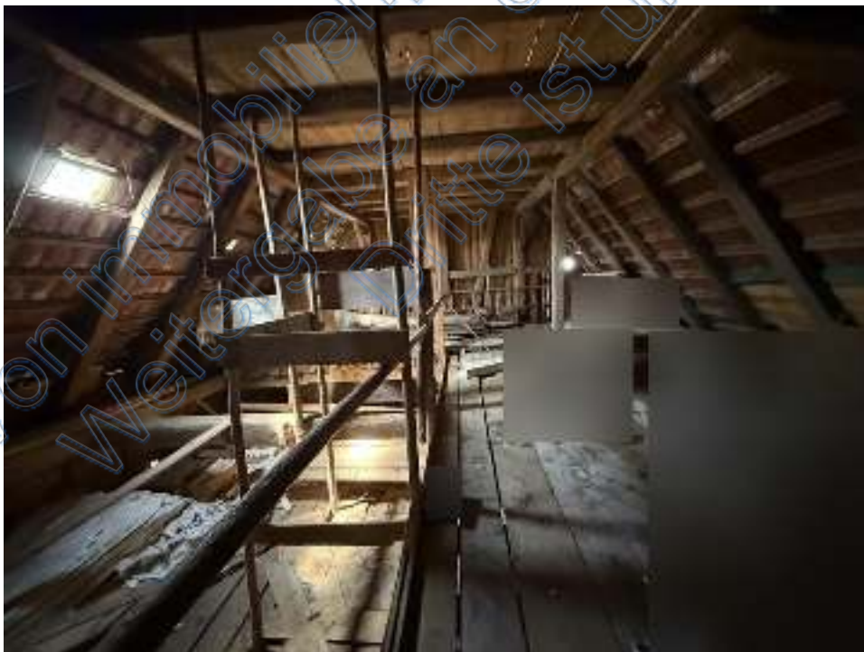
Bild 22 Dachgeschoss über Wohn- und Ökonomieteil
