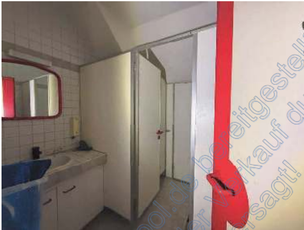
Dachgeschoss – Personal-WC nach Angabe außer Betrieb
