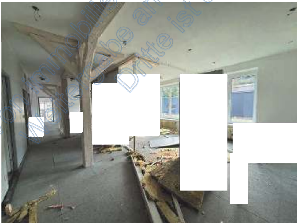
Erdgeschoss – Büros, Trennwände teilweise ausgebaut
