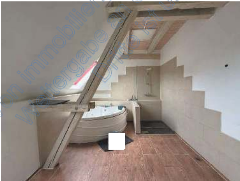
Dachgeschoss – Betriebswohnung rechts Bad
