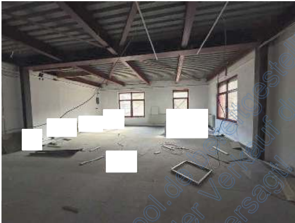
Bild 15 Untergeschoss – Anbau Büro / Lager
