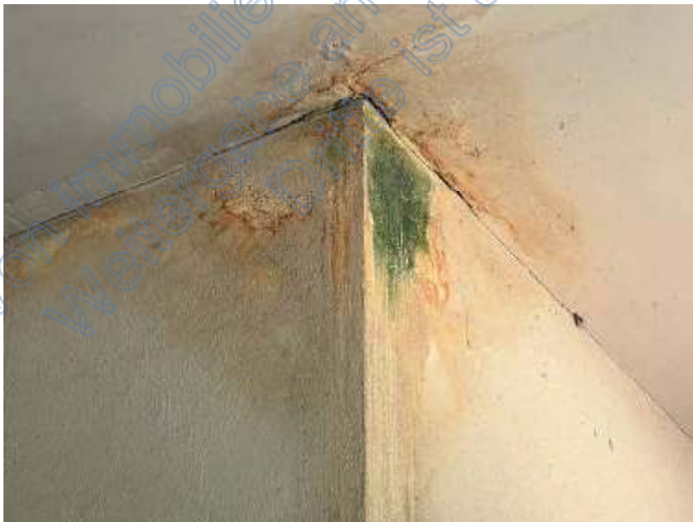
Bild 14 Untergeschoss - Feuchteschaden
