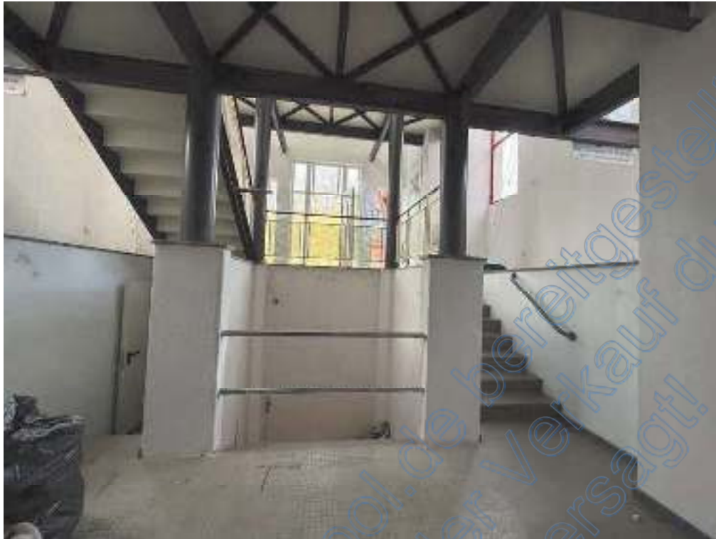
Untergeschoss – Treppenhaus mit vorbereitetem Aufzugsschacht
