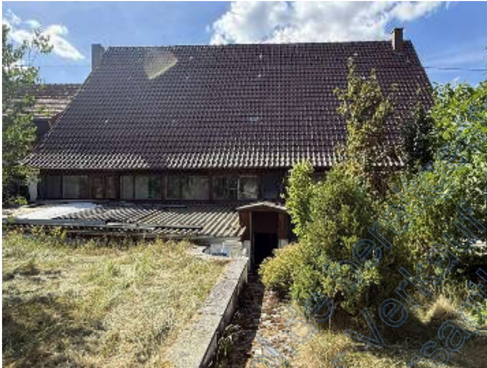
Ansicht Südost, links Werkstatt, Bildmitte Zugang zum Erdgeschoss
