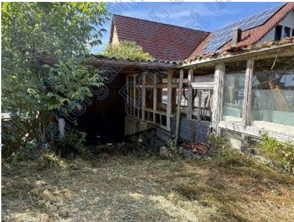
Gewächshaus mit angebautem Geräteunterstand
