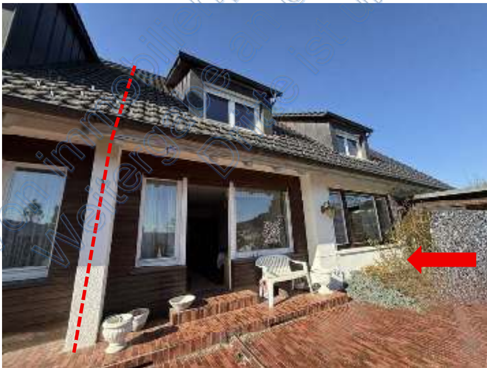
Ansicht Süd, rechte Fotoseite unbeheizter Wintergarten
