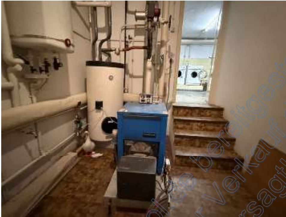
Bild 7 Untergeschoss – Heizraum, im Hintergrund Waschküche
