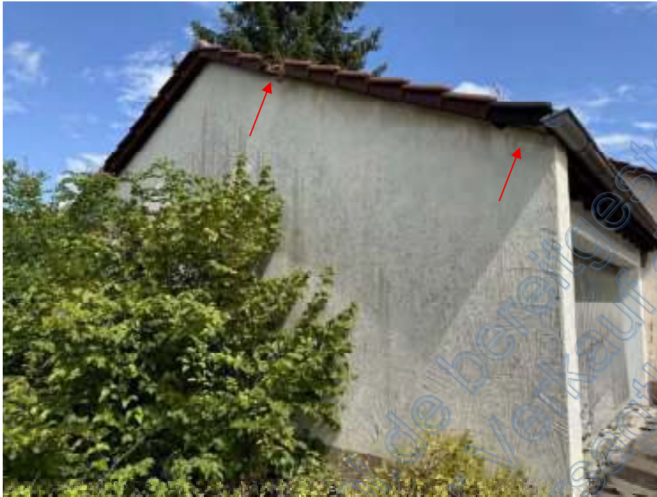
Garagen – Schaden am Ortgang und Riss
